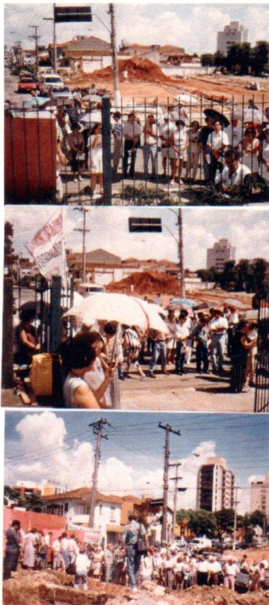
Figura 9 - Cenas da demolição da Igreja. Fonte: Sandra Santo Ambrósio.
