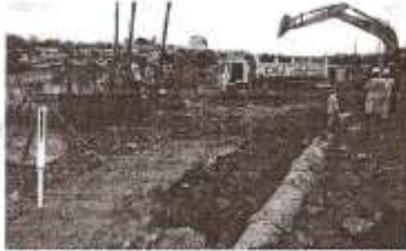
CONSTRUÇÃO DE GALERIA PLUVIAL - Urbânização de rede de esgoto público
