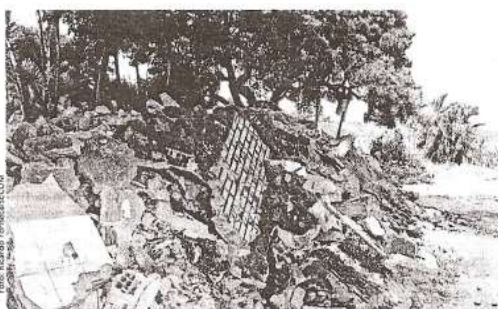
Construções irregulares em área de proteção são demolidas
