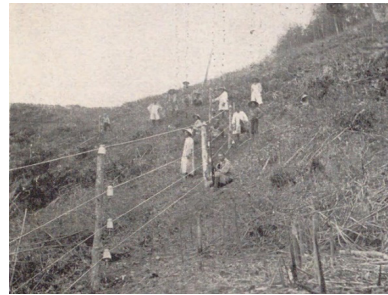
圖 5 警備員執行鐵條網修補作業中
