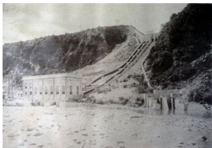
圖 8 后里水力發電所
