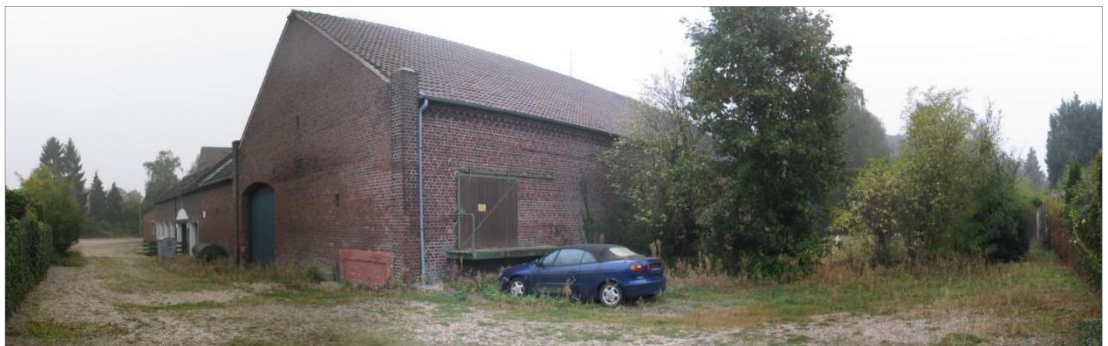
Abb. 6-8: Gebäudekomplex sowie Wiesenflächen, Gehölze und Abstellplatz im Umfeld der Hofanlage. Blickrichtung: Nordwest (Abb. 6), Nordost (Abb. 7) bzw. Südost (Abb. 8).
