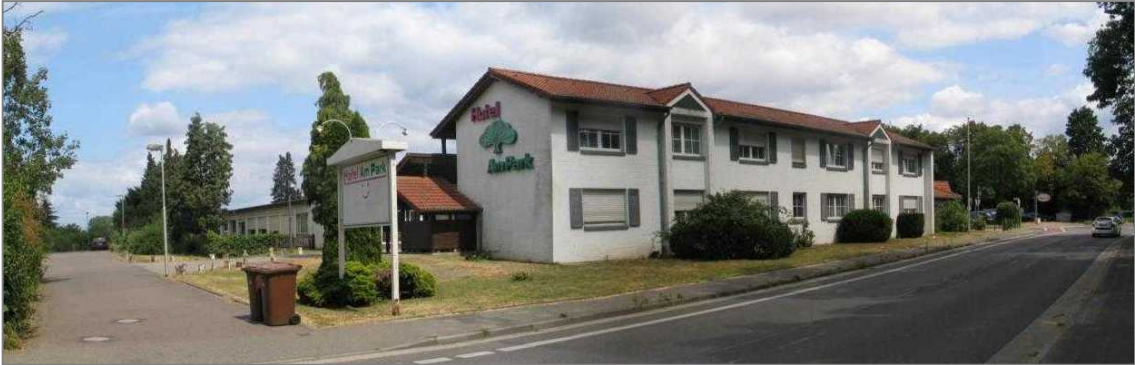
Abb. 14: Hotelkomplex an der Parkstraße/L 26
