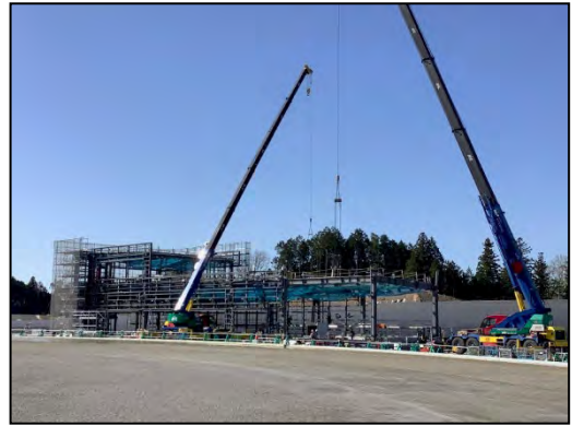
⑫施設建設工事 (建築工事、2021 年 3 月)
