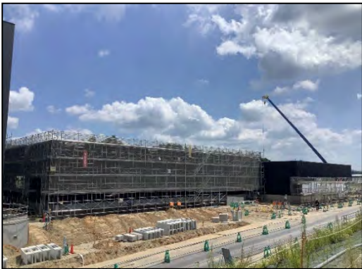
⑬施設建設工事 (建築工事、2021 年 7 月)
