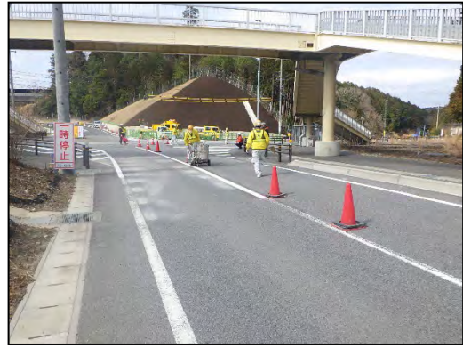
②道路工事 (2021年3月)
