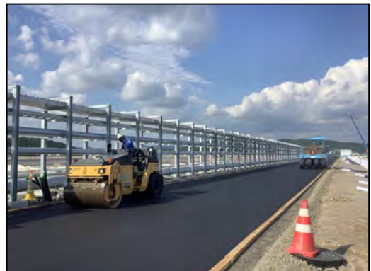
⑯施設建設工事 (舗装工事、2021 年 7 月)
