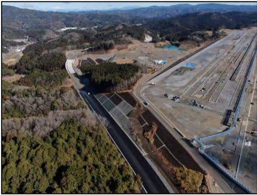
⑪道路工事 (2021 年 1 月)
