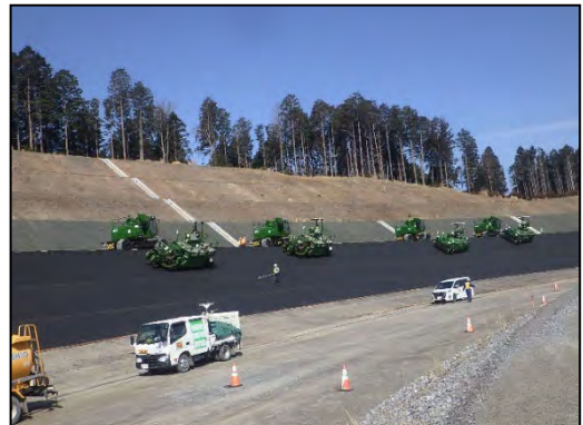
⑭施設建設工事 (舗装工事、2021 年 3 月)
