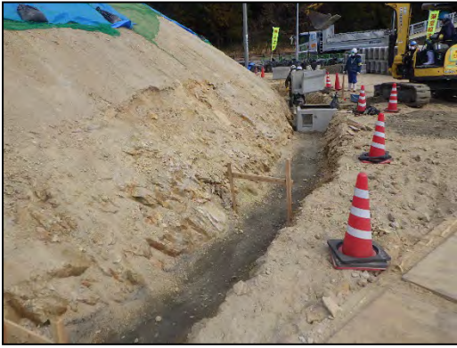
①道路工事 (2021年2月)
