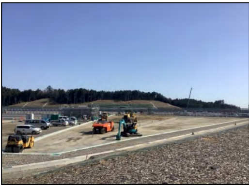
⑮施設建設工事 (舗装工事、2021 年 4 月)
