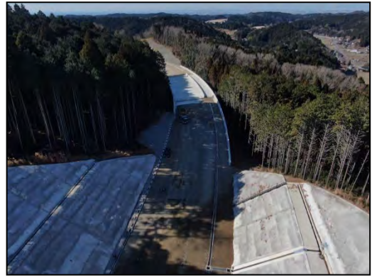
⑩造成工事 (橋梁工事、2021 年 1 月)
