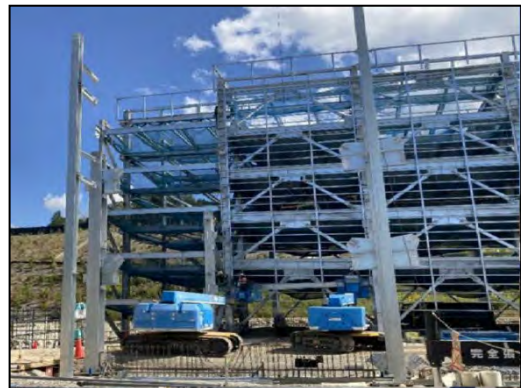
⑧施設建設工事 (建築工事、2021年10月)
