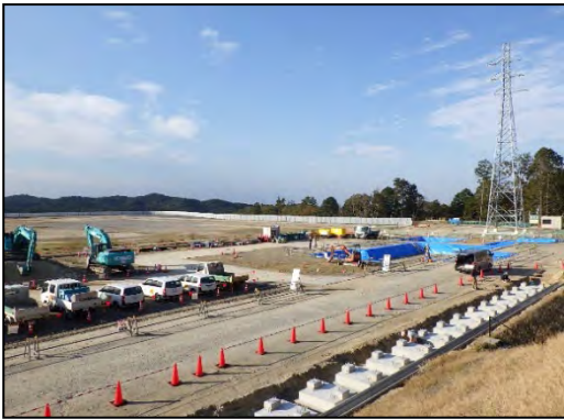
③施設建設工事 (建築工事、2021年10月)
