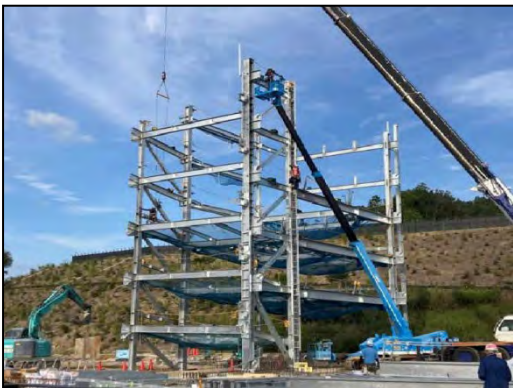
⑦施設建設工事 (建築工事、2021年10月)
