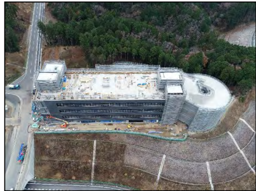
④施設建設工事 (建築工事、2021年1月)
