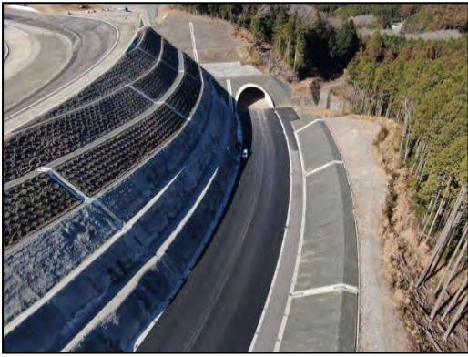
⑨造成工事 (トンネル工事、2021 年 1 月)
