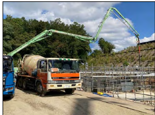
⑥施設建設工事 (建築工事、2021年10月)
