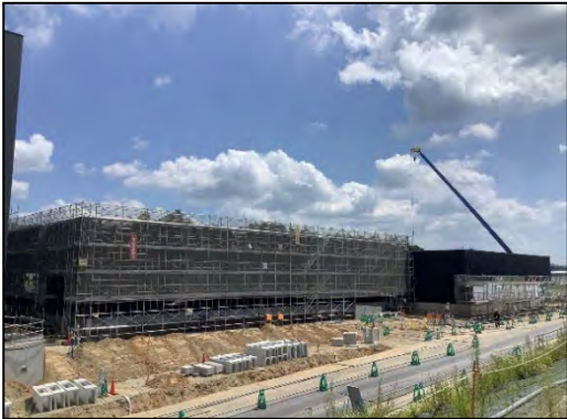
⑬施設建設工事 (建築工事、2021 年 7 月)
