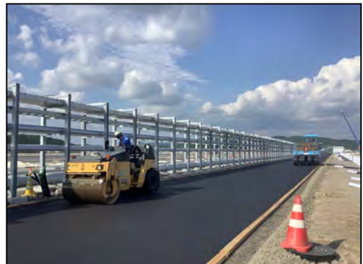
⑯施設建設工事 (舗装工事、2021 年 7 月)
