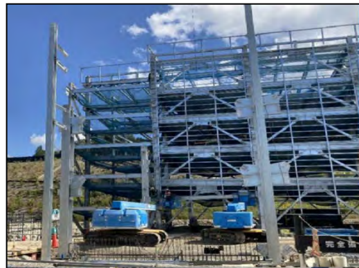
⑧施設建設工事 (建築工事、2021 年 10 月)
