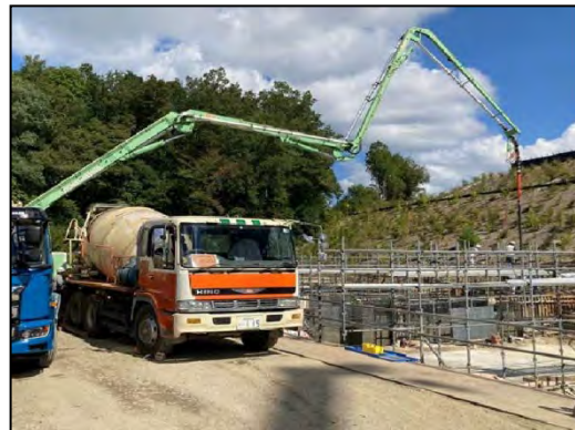
⑥施設建設工事 (建築工事、2021 年 10 月)
