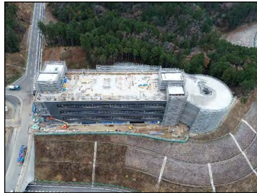
④施設建設工事 (建築工事、2021 年 1 月)
