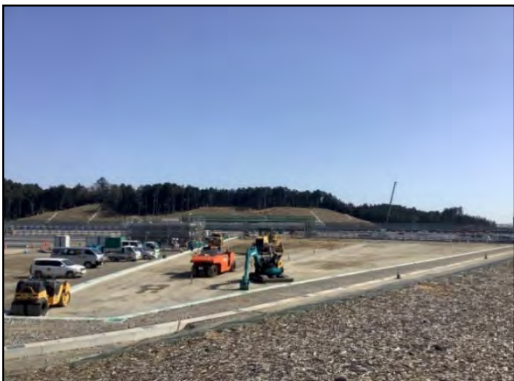
⑮施設建設工事 (舗装工事、2021 年 4 月)
