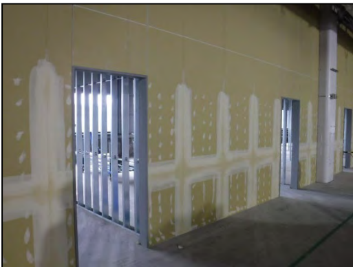
⑤施設建設工事 (建築工事、2021 年 1 月)
