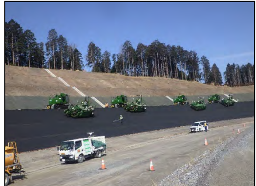
⑭施設建設工事 (舗装工事、2021 年 3 月)
