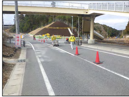
②道路工事 (2021 年 3 月)
