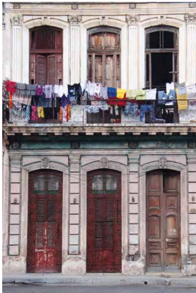
Mycket återstår att upprusta, och många byggnader är i sämre skick än detta. Målsättningen är att de boende ska kunna bo kvar efter upprustning. Foto Jacqueline Cederström
