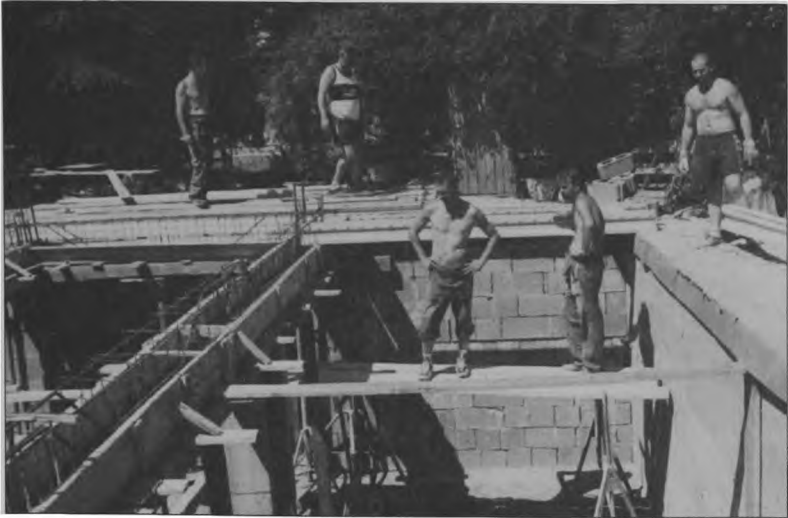
Az alsógödi templom földszinti földemjének építése
