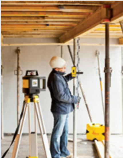
Lasernivelliere sind die „Arbeitstiere“ unter den Bauvermessungsinstrumenten. Ein Laser ist eine ideale Ergänzung bzw. Alternative zum klassischen Nivellier für viele Routinearbeiten auf der Baustelle.
