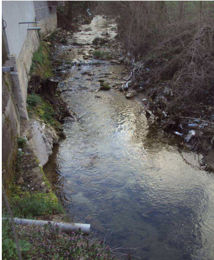
Слика бр. 33: Испуст отпадне воде у Локањску ријеку
