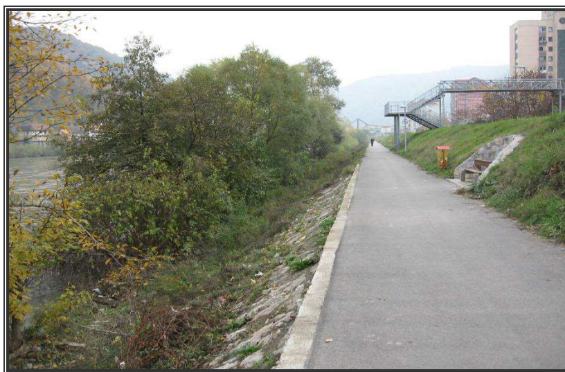
Слика бр. 22 : Уређена обала ријеке Дрине у подручју града
