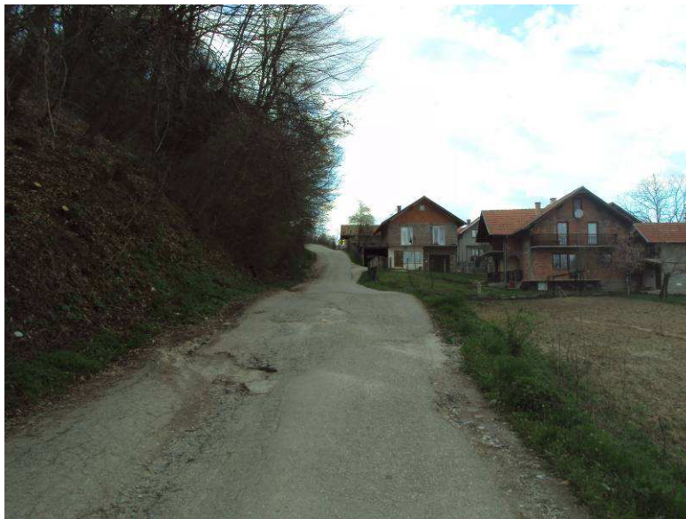
Слика бр. 15 : Пут Крижевићи – Мотово оштећен клизањем
