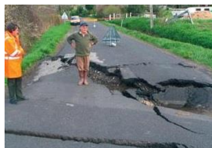
Figure 64 : Illustration des conséquences d'épisodes d'inondation ou de retraits gonflement des argiles
