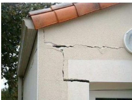
Figure 32 : Illustrations du phénomène de Retrait Gonflement des Argiles 83
