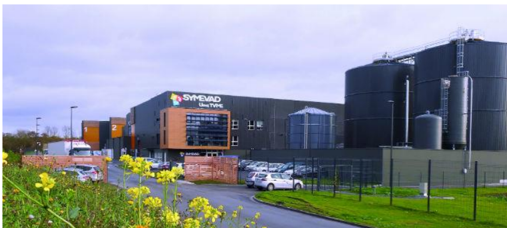
Figure 69 : Unité de Tri Valorisation Matière et Energie de SYMEVAD à Hénin-Beaumont où sont traités les déchets de la Communauté d'Agglomération du Douaisis (Source : site du SYMEVAD)
