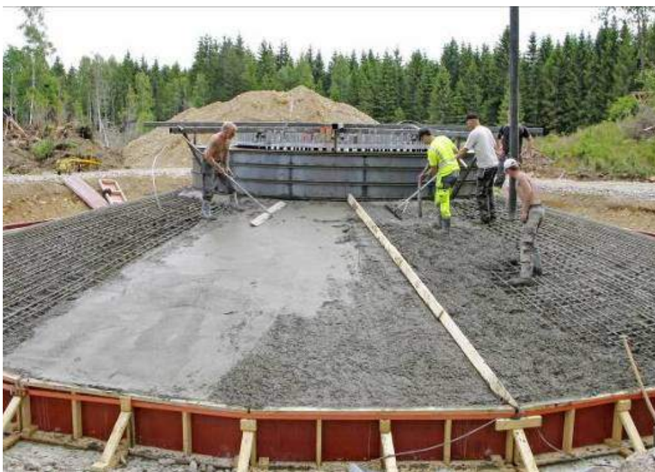
Figur 4-7. Gjutning av fundament för vindkraftverk vid Ryningsnäs i Hultsfreds kommun (foto Hans Blomberg).
