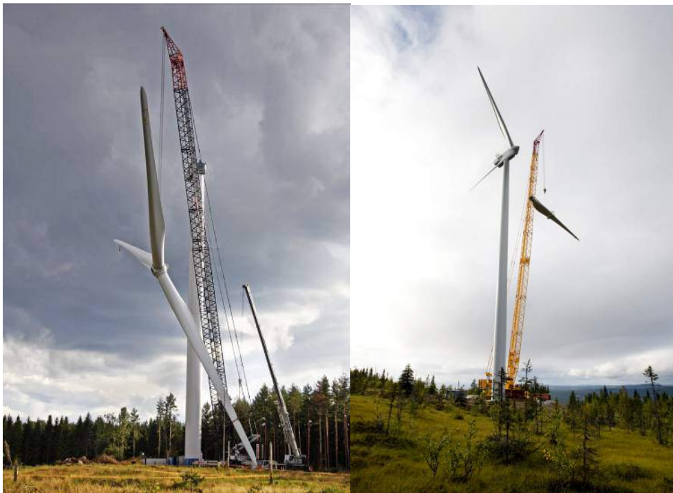
Figur 4-9. Installation av hela rotorn (t.v) Ryningsnäs i Hultsfreds kommun och blad för blad (t.h) Stor-Rotliden (foto Hans Blomberg).
