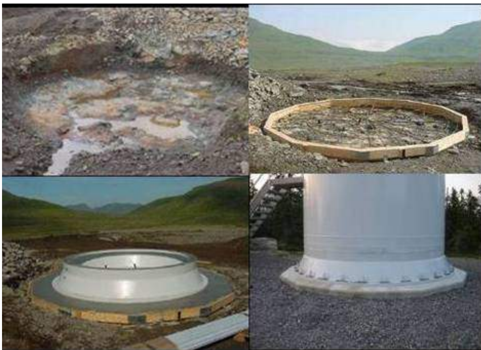
Figur 4-8. Byggnation av bergförankrade fundament.
