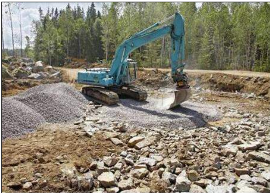
Figur 4-4. Markarbeten i samband med byggnation av vindkraftverk vid Ryningsnäs i Hultsfreds kommun (foto Hans Blomberg).
