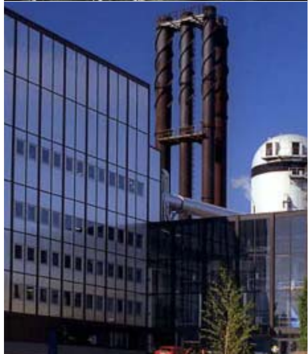
Top picture: Vattenfall Värme Uppsala AB. Bottom picture: Drefviken Värmeverk.
