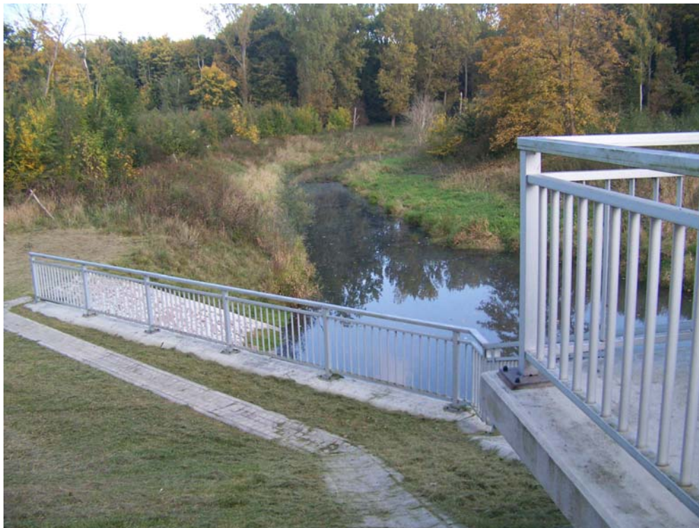
Bild 12: Absperrbauwerk Kleinliebenau und Luppewildbett (Luppefluss unterhalb des Bauwerkes westlich Kleinliebenau)
