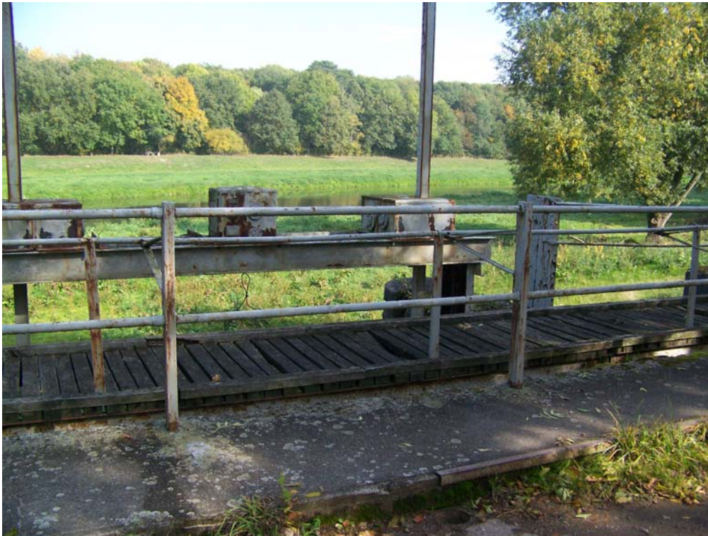
Bild 9: Wehr Kleinliebenau Neue Luppe - Luppewildbett (ehemaliger Luppefluss)
