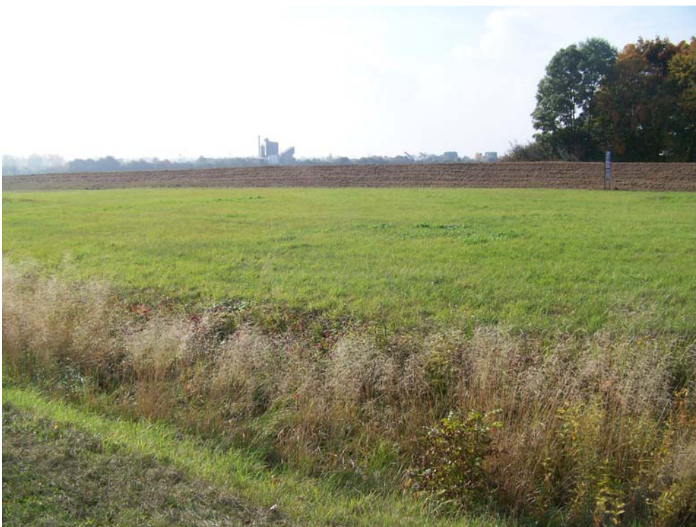
Bild 6: Hochwasserschutzanlagen nördlich Kleinliebenau von der B186 aus gesehen
