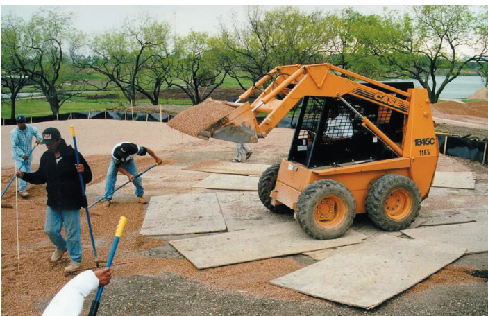
Se utiliza el contrachapado pesado para prevenir daño a las líneas de drenaje del equipo pesado.
