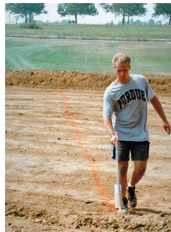
Pintura de aerosol y una pistola marcador lo hacen drenaje que intentar hacer curva fácil de diseñar el patrón de línea de drenaje.
