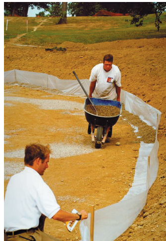
láminas de 6 a 8 ml de plástico son fácilmente adyacentes a los greens. disponibles en tiendas de ferretería y funcionan bien para la barrera de capilaridad.
