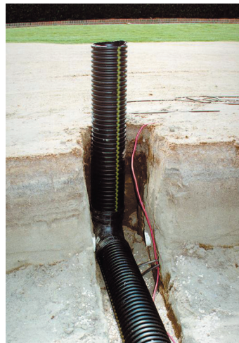
Salga el alambre cerca de la "limpieza al ras" o cerca de un aspersor de modo que el extremo del cable se puede encontrar fácilmente.
