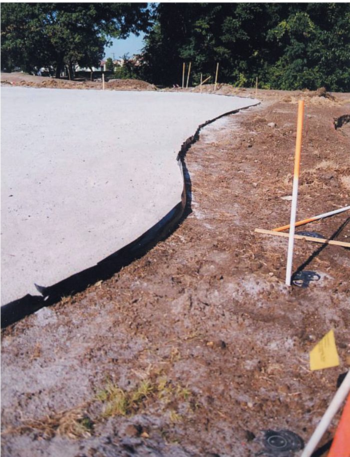
de los alrededores se erosione sobre el green. Se elimina más tarde con un cuchillo de alfombra o una herramienta similar.
