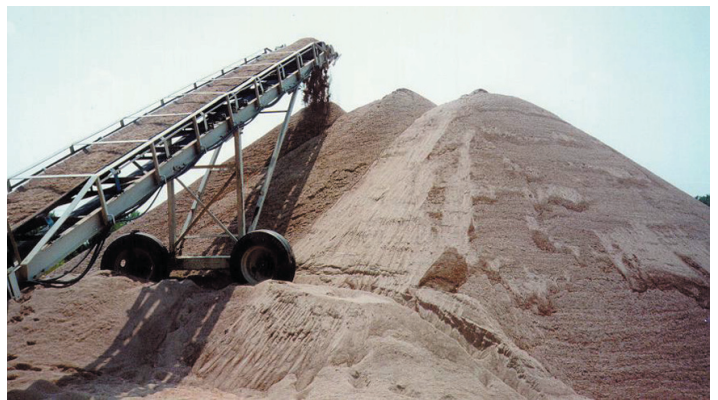
Una visita a la planta de arena y grava ayudará a que todos los involucrados en el proyecto entiendan mejor las necesidades del proyecto y los buenos procedimientos de control de calidad.
