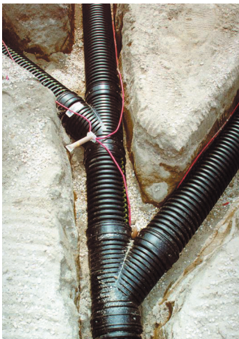
Coloque un cable de riego #14 en cada zanja para permitir una fácil ubicación en una fecha posterior mediante un dispositivo de seguimiento de alambre.
