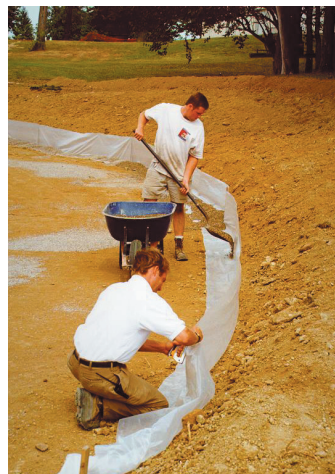
La grava se agrega a la parte interior del cuchillo de la alfombra se utiliza para cortar la cavidad sobre el plástico para mantenerlo en su lugar
