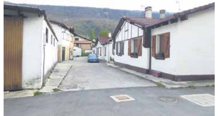
Ur beltzena, euri urena eta ur hornidura sareak eta zoladura berrituko dituzte.
