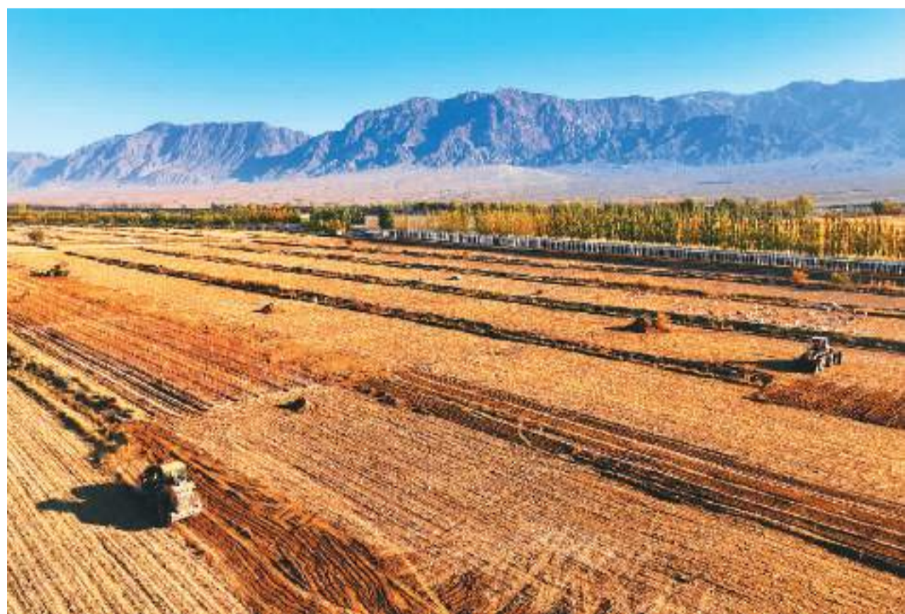
甘肃省持续推进高标准农田建设，截至2022年底已累计建成高标准农田2510万亩，有力改善了农业生产基础条件，粮食增产效果明显。今年以来，甘肃继续出台系列政策举措，支持各地抢抓秋冬耕建设窗口期，进一步加快高标准农田建设。图为甘肃农垦集团张掖农场高标准农田建设项目工地上，大型机械在进行土地平整作业。
