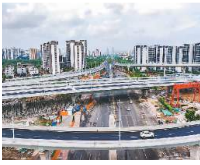
10月29日，海南省海口市美兰国际机场快速通道项目实现主线桥通车。作为海南自贸港建设重点民生工程，美兰国际机场快速通道项目由海口市路桥建设投资有限公司建设、中铁上海工程局集团施工，总投资额21.19亿元，路线全长约5.37公里，项目建成后将有效提升区域通行便利度。
