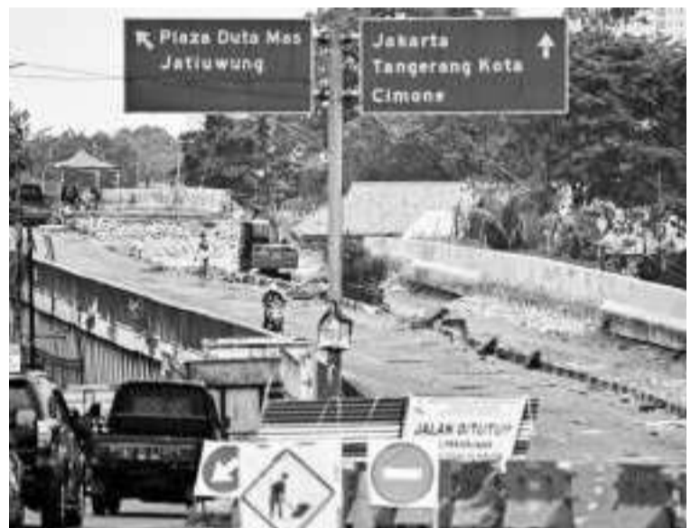
丹格朗 Cibodas 高架路修复项目 10月31日，公共工程与民居部声称，万丹省丹格朗市全长380米的 Cibodas 高架路正处于施工阶段，同时也建造 Balaraja Barat B 高架路，合同价值约达910亿盾，并预定2024年6月份竣工。
