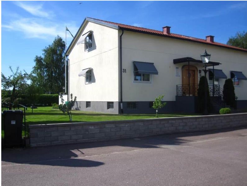
Fig. 3. Nyanlagd mur och gräsmatta. 2012. Foto: M. Nilsson
