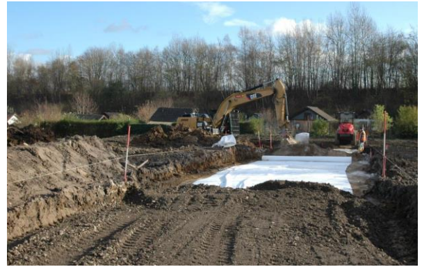
Neubaugelbiet Hagen-Halden Lennestraße Foto: HEG
