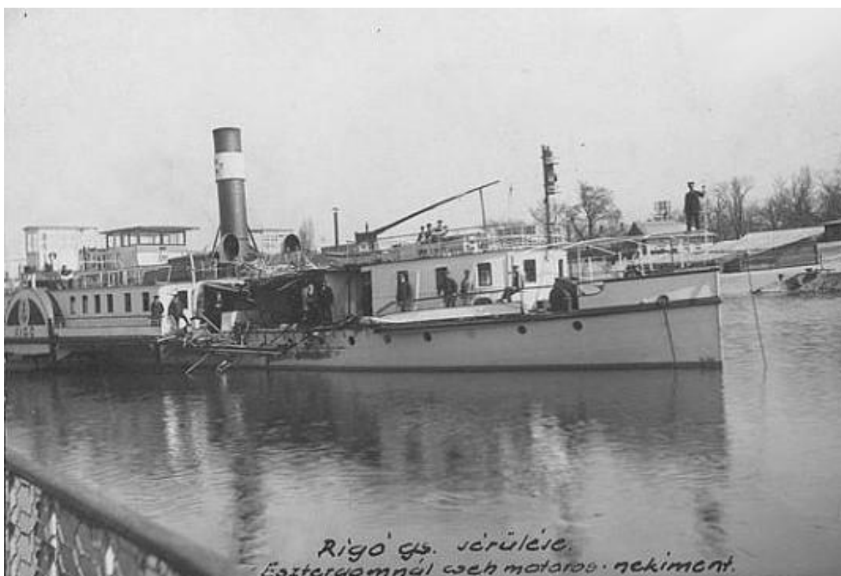
6. ábra: A RIGÓ (ex-FERENCZ FERDINÁND FŐHERCZEG) sérülése a cseh motorossal való ütközés után 1919-ben.
