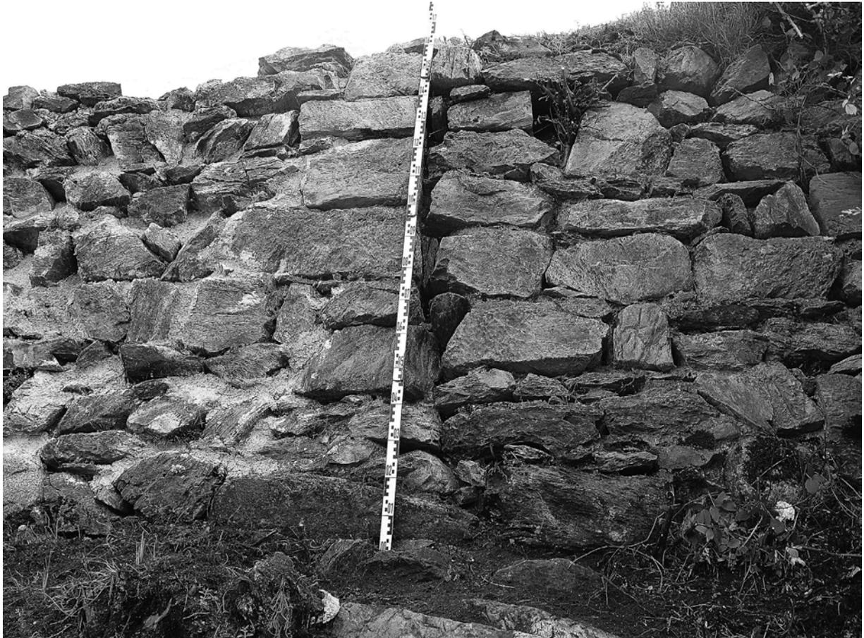
*fig. 6. Coup de sabre dans le mur d'enceinte à l'angle formant la tour basse dite du Campanal. Malgré l'absence de chaînage, les murs n'ont pas pu être construits au cours de phases différentes. Il s'agit soit d'une pause de chantier, soit d'une technique volontairement usitée pour éviter que le mur de l'enceinte n'entraîne celui de la tour vers le vide. Crédit Florence Guillot.*
