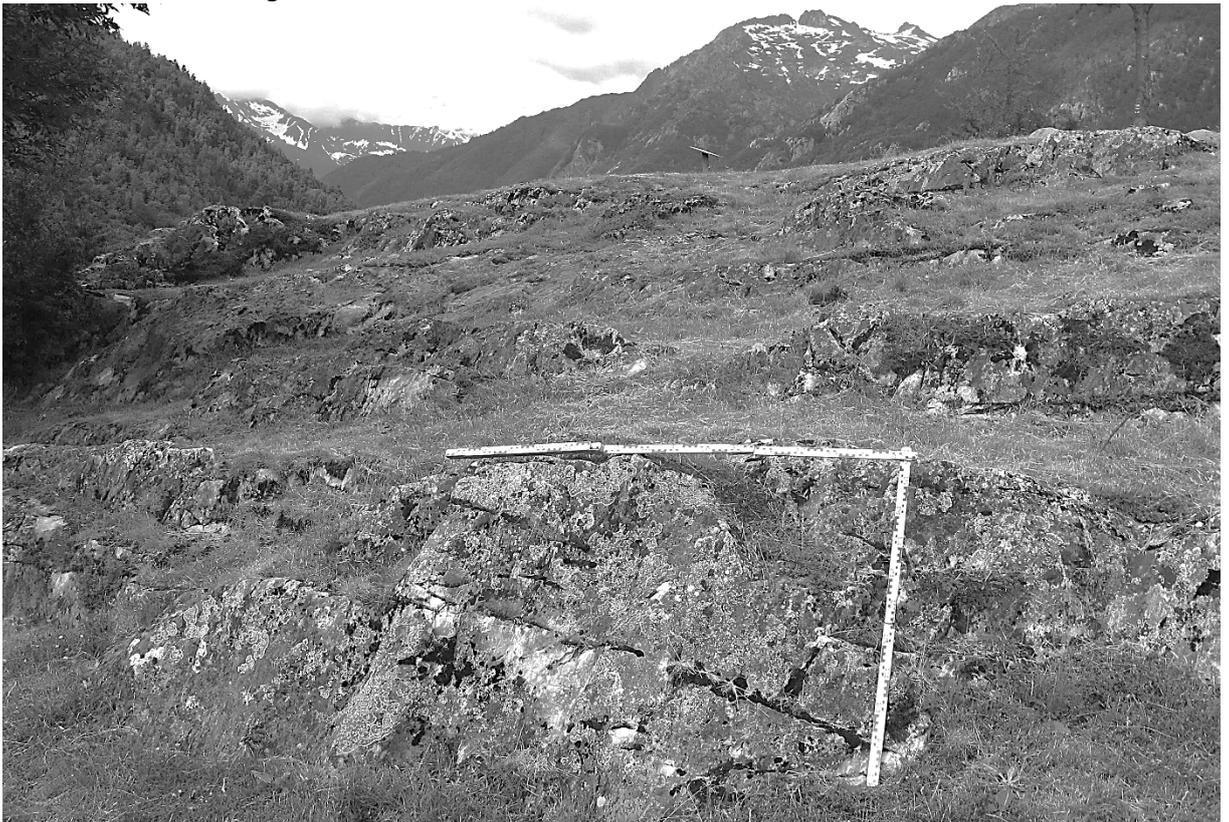
Les moellons utilisés dans le mur d'enceinte sont juste équarris et sont assemblés de façon assez désordonnée même sur les parements (fig. 4). Certes, on repère quelques tentatives d'horizontalité des assises, mais l'irrégularité des moellons utilisés aboutit à un vrai *opus incertum*. Maçonnés au mortier de chaux, mais non bloqués, ces murs atteignent à peine 90 à 95 cm d'épaisseur, ce qui est tout à fait
