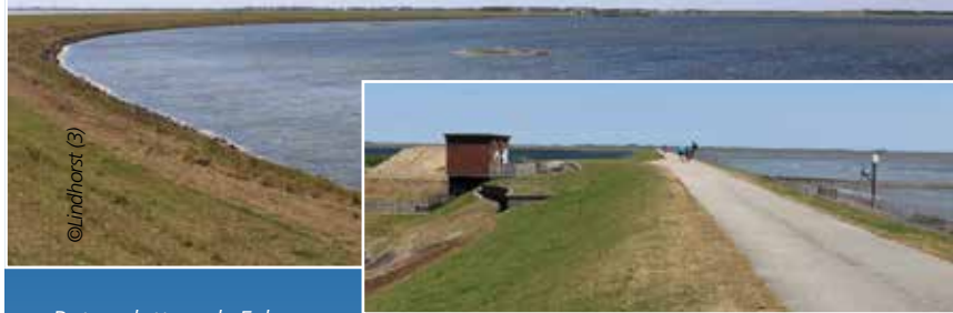
Betonplatten als Fahrbahn auf dem Sperrdamm des Rantumer Beckens. Befüllt durch zwei Pumpen mit Wasser aus dem Wattenmeer (re.) bot die künstlich angelegte Fläche (li. oben) zwei tideunabhängige geschützte Start- und Landebahnen von 3.500 und 2.700 Meter Länge in den beiden Hauptwindrichtungen. Ein Pumpwerk sorgte für einen Wasserstand, der zwischen 3,50 und 4 Metern schwankte. Nach 1949 wurden die Pumpen demontiert und weite Teile des Rantum-Beckens fielen trocken.
