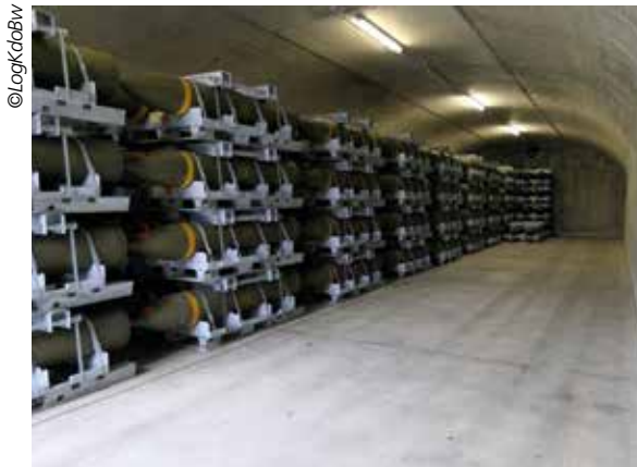
Werterhaltende Lagerung von Abwurfmunition der Luftwaffe.
