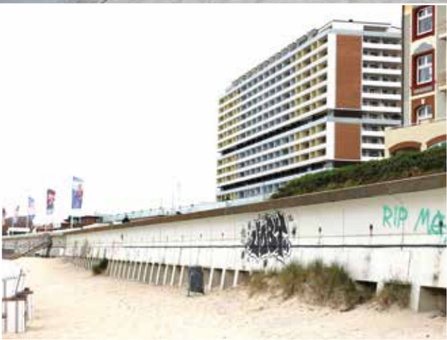
Die Westerländer Promenade – einst auch als Schutzwall gegen Landungsversuche errichtet. Weil das Mauerwerk abbricht, wurde 2023 eine Wand aus 4,4 Meter hohen und 13 Tonnen schweren Stahlbeton-Fertigteilen unmittelbar vor die alte Ufermauer gesetzt.
