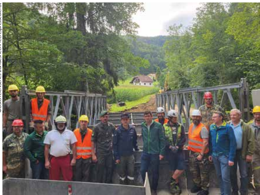
Einsatzkräfte und Pioniere des österreichischen Bundesheeres beim Wiederaufbau zerstörter Straßen und Brücken im August 2023.
