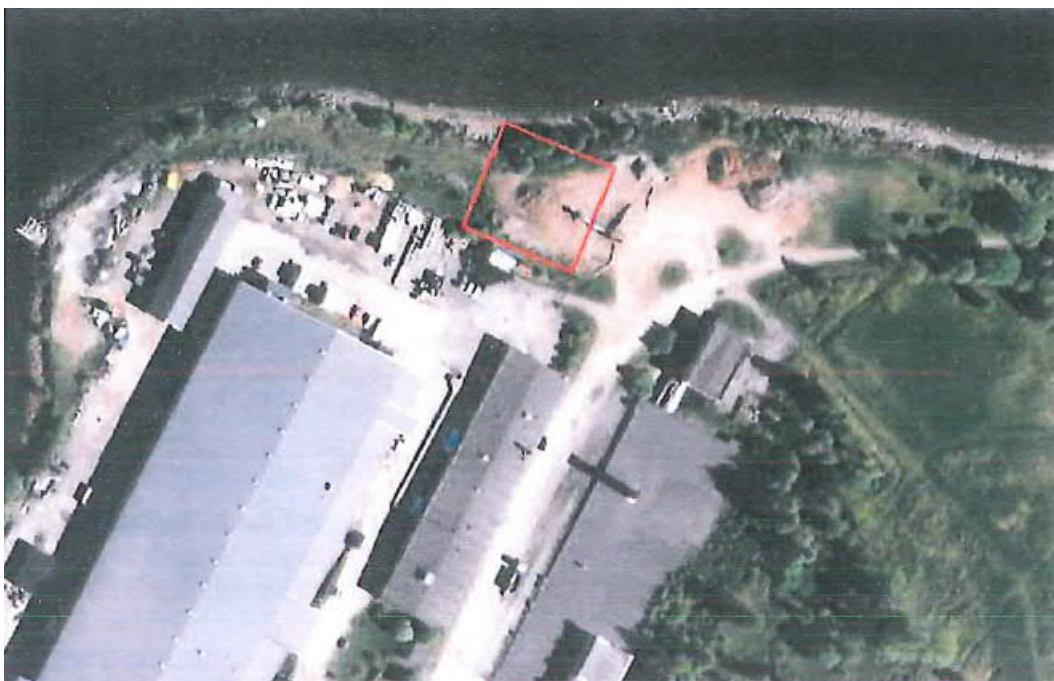
Figur 5. Sanering i samband med byggnation av nya oljepannor har utförts inom det markerade området. Förorening av koppar och krom fanns i ett svart skikt.
