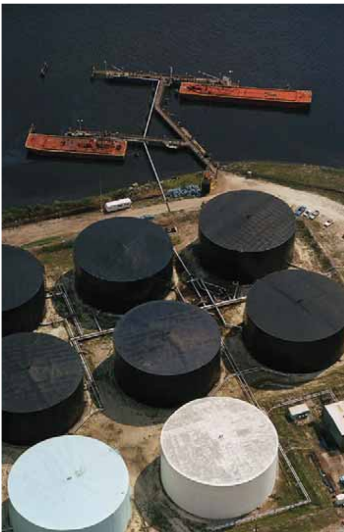
Anwendungsbeispiel für Gas-Ex-Zone 0: Das Innere von Flachbodentanks eines Öl-Terminals
