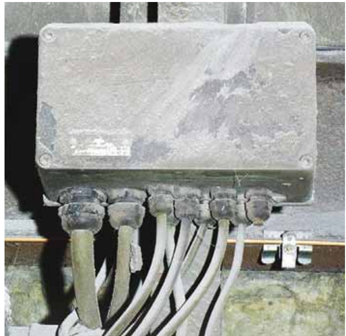
Beispiel Staub-Ex-Zone 21: Explosionssgeschützter Klemmenkasten
