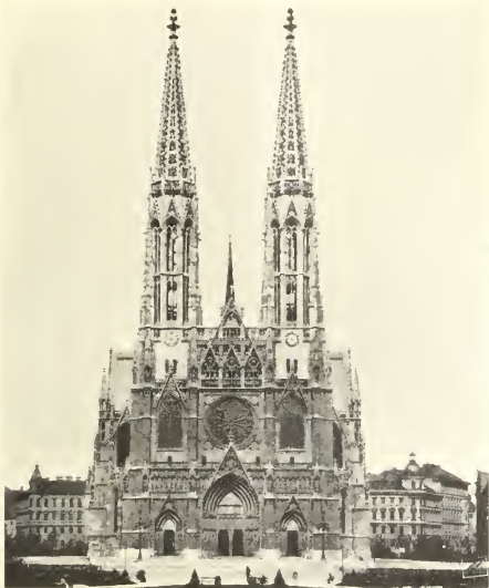
Fogadalmi templom (ép. Ferstel Henrik).
