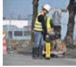
Mit dem Leica Digisystem lassen sich unterirdisch verlegte Rohre und Leitungen einfach aufspüren. Das Digisystem wurde speziell dafür konzipiert, menschliche Fehler zu reduzieren und die Sicherheit durch zahlreiche intelligente und einzigartige Leistungsmerkmale zu erhöhen.
