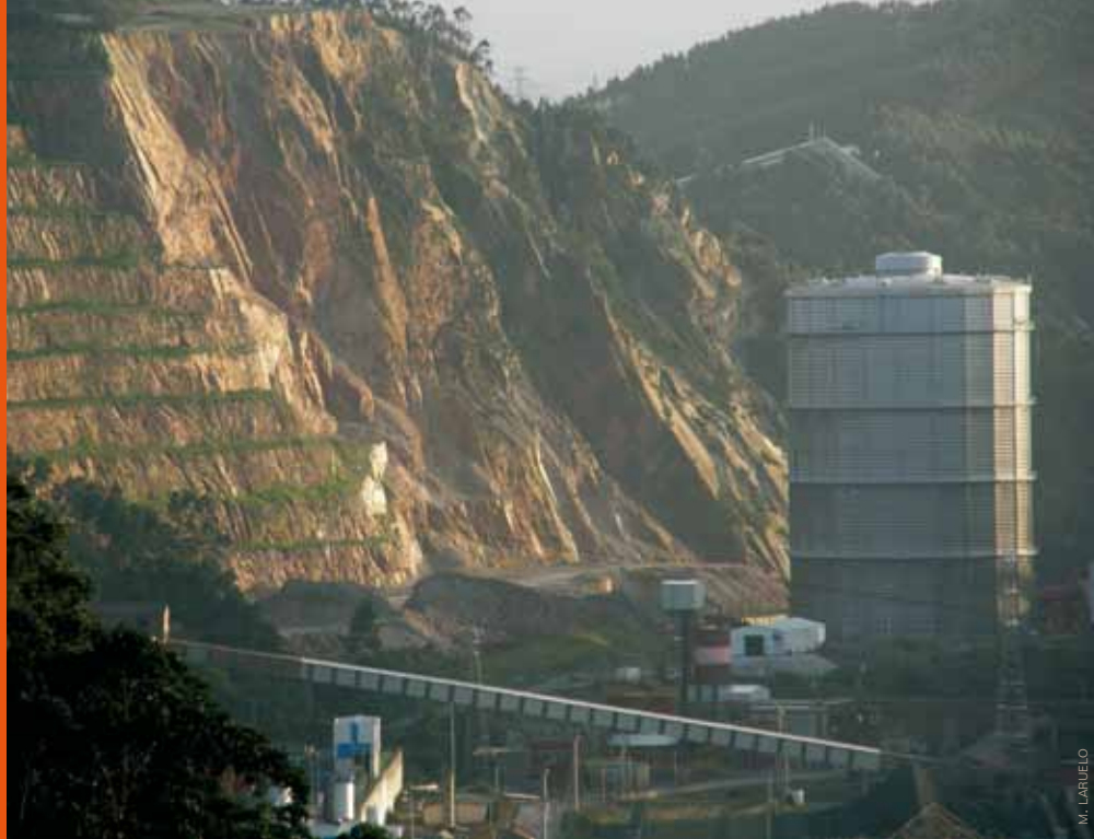
■ Gasómetro de la térmica de HC de Aboño, situado a menos de cien metros de las canteras.
