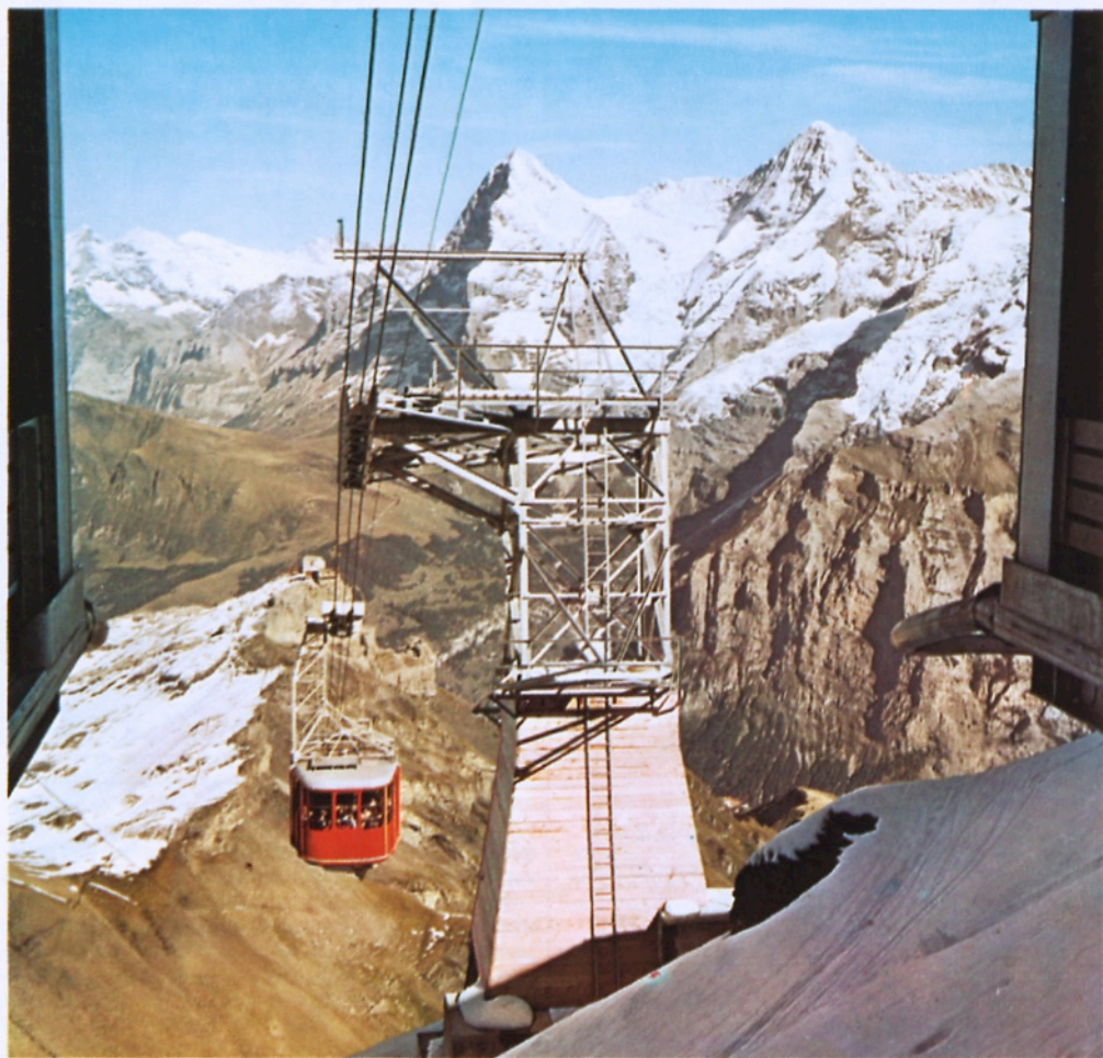
Arriba, teleférico en la montaña de Montserrat (Barcelona) de 1.100 m de longitud en tres vanos de 200, 300 y 600 m. Abajo, teleférico de Shilthorn en los Alpes Suizos, donde son especialmente numerosas estas instalaciones para uso del turismo. (Foto Edistudio, Olavarrieta.)
