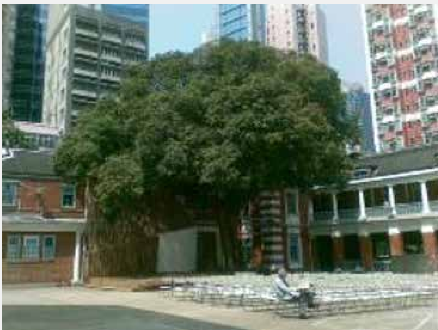
活化工程前的中區警署建築群（今大館） Central Police Station Compound (Present-day Tai Kwun) before revitalisation works
