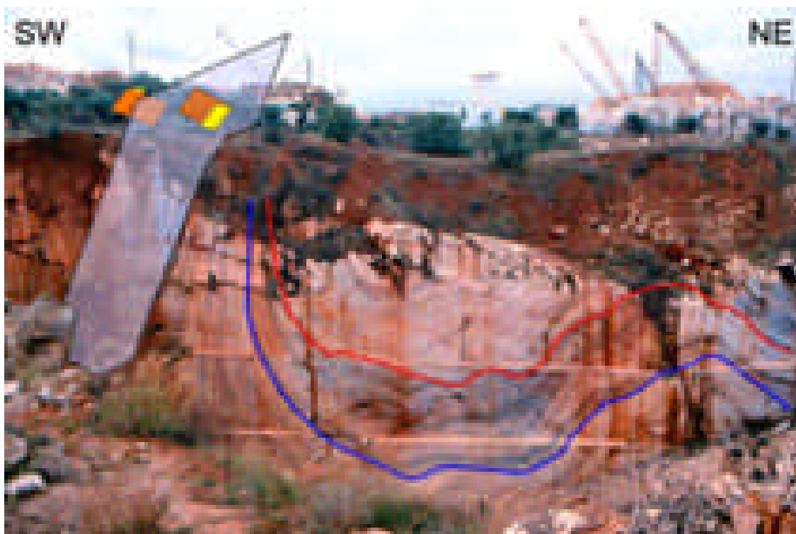
Fig. 4.62 – Exemplo do desenvolvimento de uma banda de cisalhamento, sob condições de deformação em regime dúctil, por estiramento do flanco Sudoeste da dobra em sinforma que se podia 9 observar numa pedreira abandonada situada a Sul da pedreira da empresa “Marmetal” situada na EN 255 entre Borba e Vila Viçosa.
