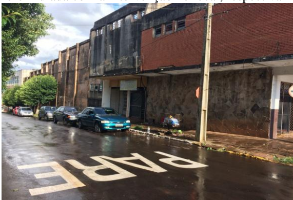
Figura 82 e 83: Fachada Norte localizada na av. Benjamin Constant. Fachada atual do imóvel, e fachada reformulada com a intervenção no local, respectivamente.
