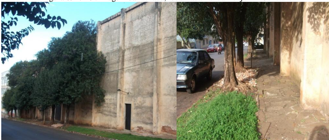
Figura 09 e 10 : imagem da fachada, localizada na rua Benjamin Constant
