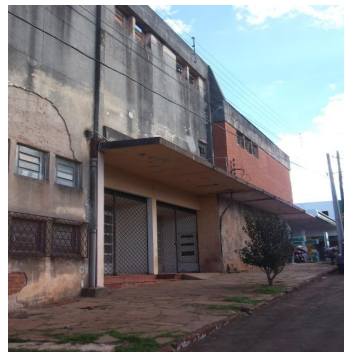
Figura 08 : imagem da entrada do cinema em 2013, se encontra desativado.
