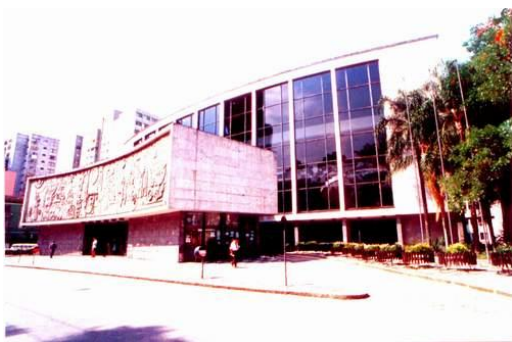
Figura 19 : imagem da fachada principal, do Teatro Guaíra, PR
