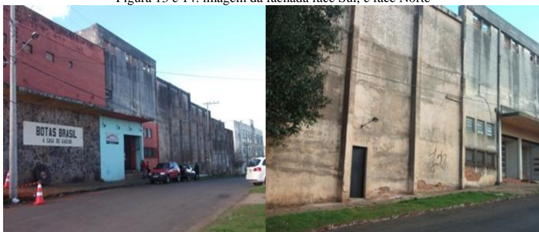
Figura 13 e 14: imagem da fachada face Sul, e face Norte
