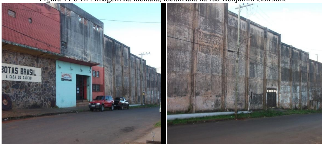
Figura 11 e 12 : imagem da fachada, localizada na rua Benjamin Constant
