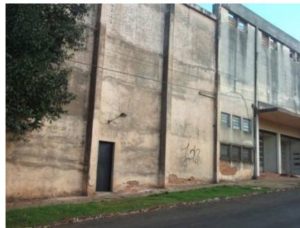
Figura 66: imagem do prédio face Norte. Fonte: autora
