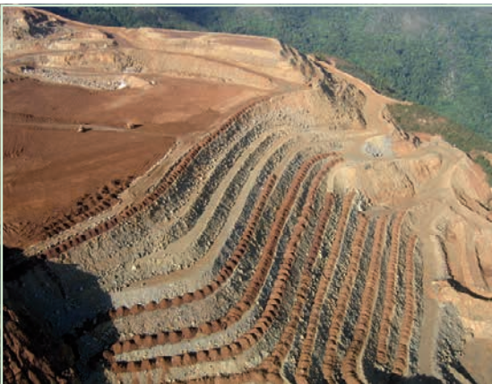
Figure 6.47 : Verse avec épandage de topsoil sur les banquettes (verse Paris Bas, Kouaoua).
