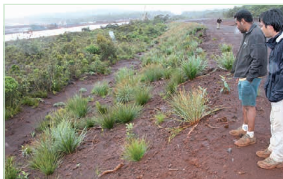
Figure 6.56 : Talus de piste recouverte de topsoil par transfert direct (Goro). Après trois ans, on constate l'implantation spontanée de nombreuses Cyperaceae et de quelques espèces ligneuses.
