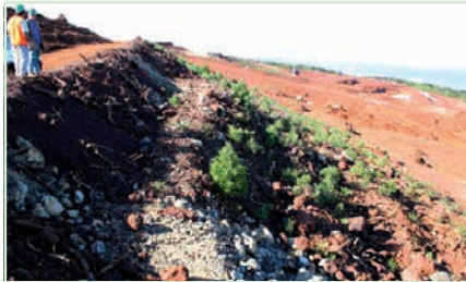
Figure 6.57 : Talus en gradins, recouverts de topsoil (Tiébaghi). Après cinq ans, implantation spontanée de nombreuses espèces (notamment Acacia spirorbis et Solanum styraciflorum ).
