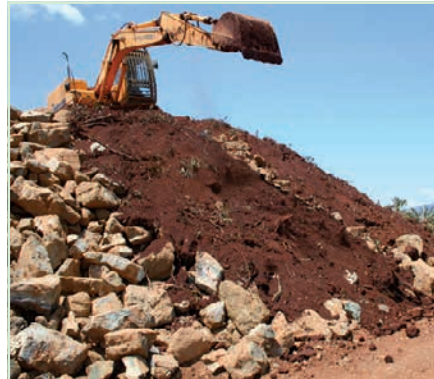
Figure 6.49 : Verse avec topsoil frais épandu sur le talus enroché (mine Vulcain, Tontouta).
