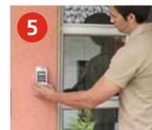
5 Je nach Set die TSE Keypad PINCODE oder FINGERSCAN Bedieneinheit an geeigneter Stelle anbringen. Die Montage ist bis zu 10 Meter von Ihrer Tür entfernt möglich.
