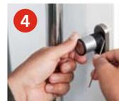
4 Befestigen des Drehknauts mit dem mitgelieferten Inbusschlüssel.
