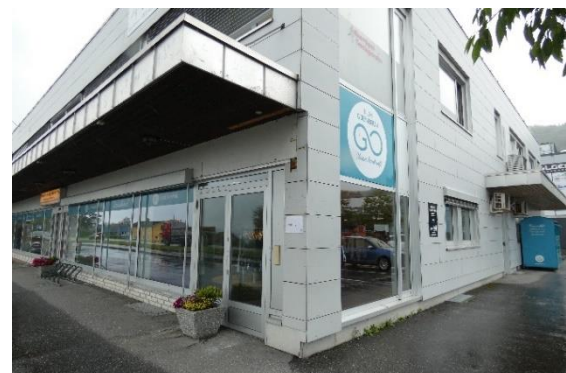
Figur 52: «Brukt er det nye nytt». Hustadvika kommune har flere tilbud om ombruk og gjenbruk. Blant disse nevnes Kirppis; et loppesupermarked etablert i Elnesvågen høsten 2020 og som ble kåret til årets bedrift Hustadvika næringsforum i 2021. Rett ved finner en også NLM Gjenbruk.
