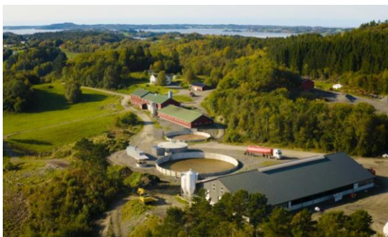
Figur 17: Oversiktsbilde av biogassanlegget på Hoemsnes.
