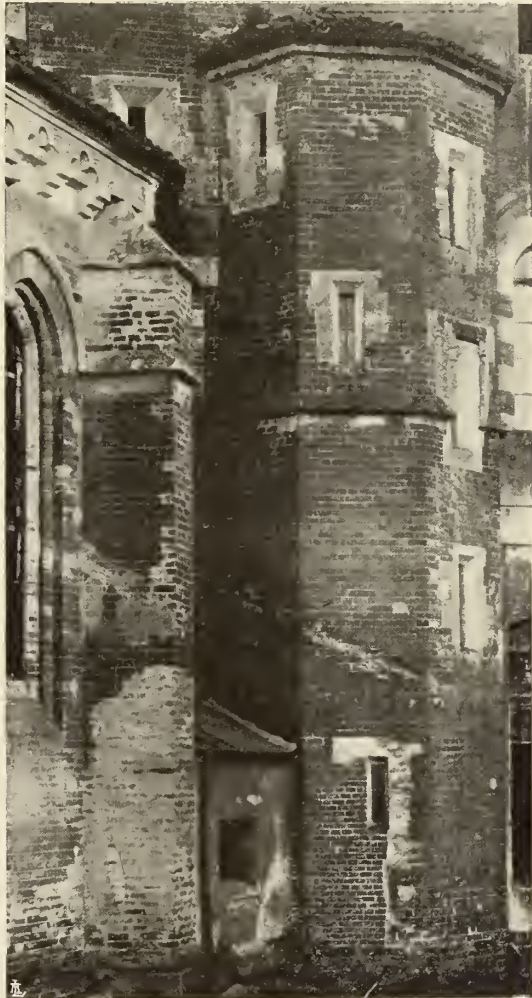
ESTERNO DELLA SCALETTA A NORD DELL'ABSIDE
