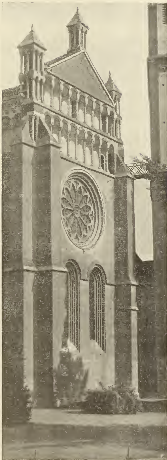
FACCIATA SUD DEL TRANSETTO
