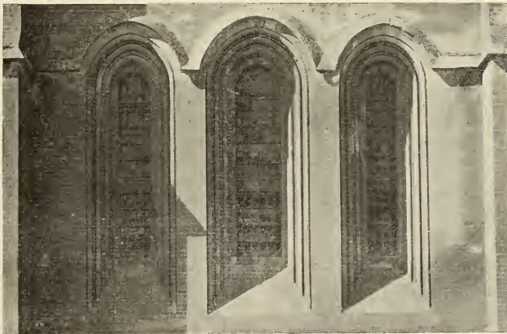
FINESTRE A TERRENO DELL'ABSIDE
