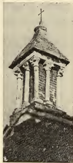
PINACOLO CENTRALE DEL FRONTONE DEL TRANSETTO A NORD
