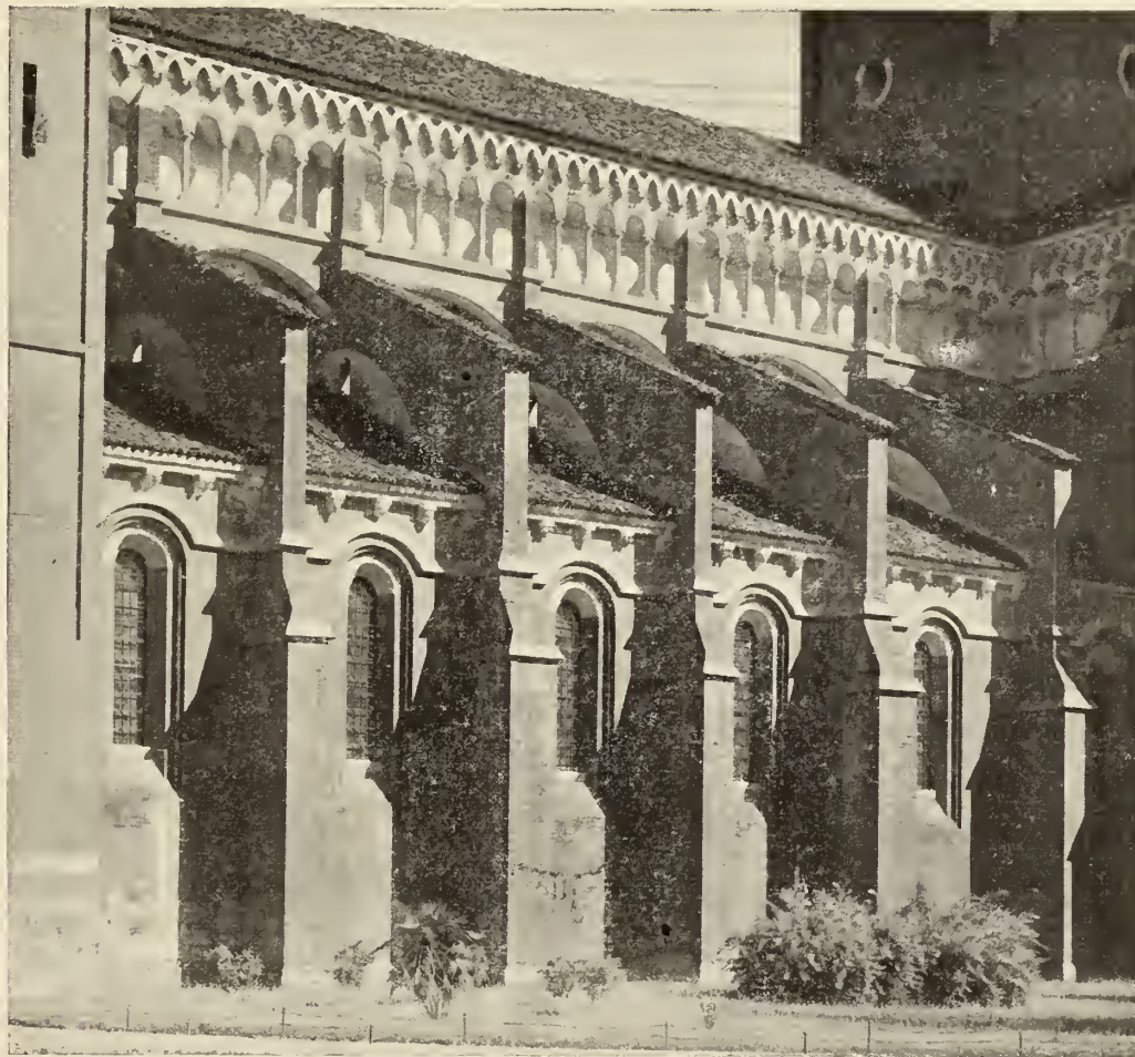
GLI ARCHI RAMPANTI DEL LATO SUD
