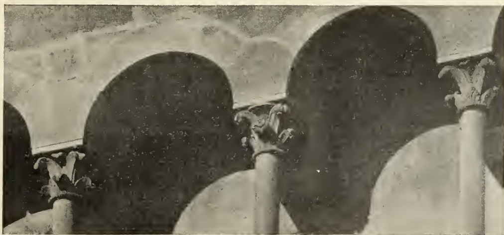
CAPITELLI DELLE GALLERIE DELLA FACCIATA
