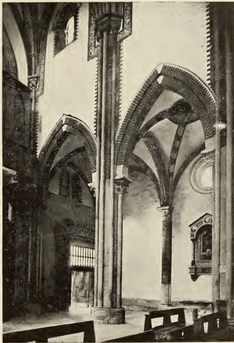
VEDUTA DEI PILONI FRA LE NAVI E ADDOSSATI AL MURO
