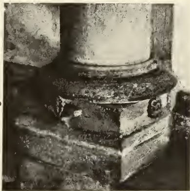
ZOCCOLO DI UN PILONE ADDOSSATO AL MURO
