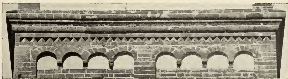
CORNICE ED ARCHETTO DEI CAMPANILI DELLA FACCIATA
