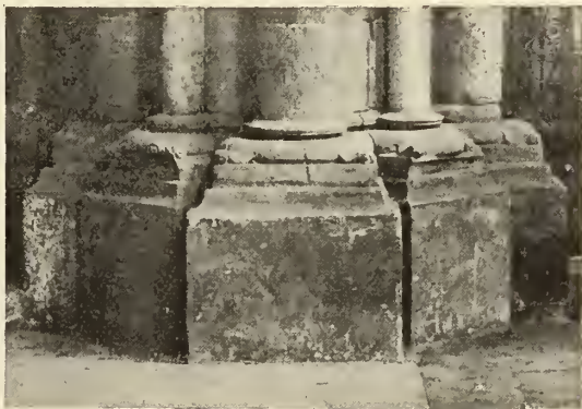
ZOCOLO DI UN PILONE DELLA NAVE TRAVERSA FRA LE CAPPELLE MINORI
