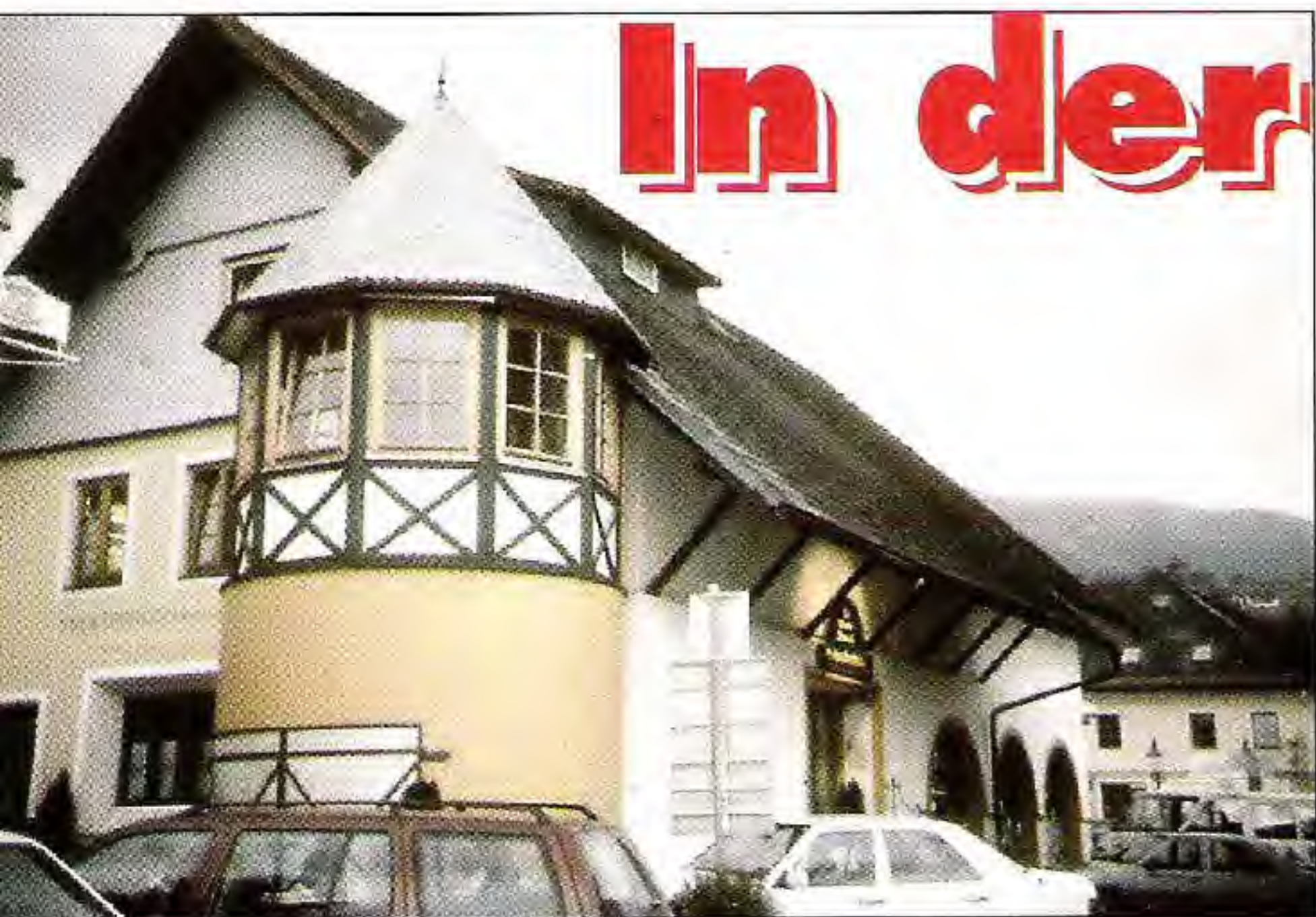
▲ In diesem malerischen Gebäude entstehen Hits wie 'Burntime' und 'Oldtimer'
