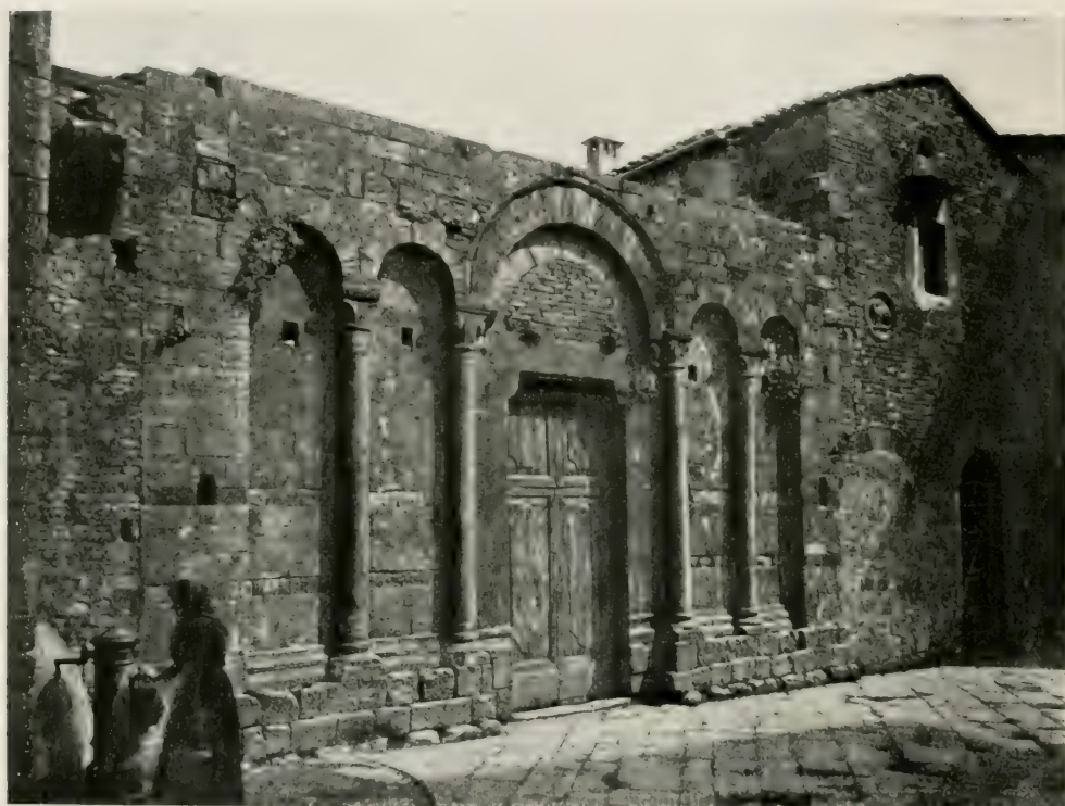
AVANZI DELL'EX CONVENTO DI S. FRANCESCO NELLA VIA S. GIOVANNI.
