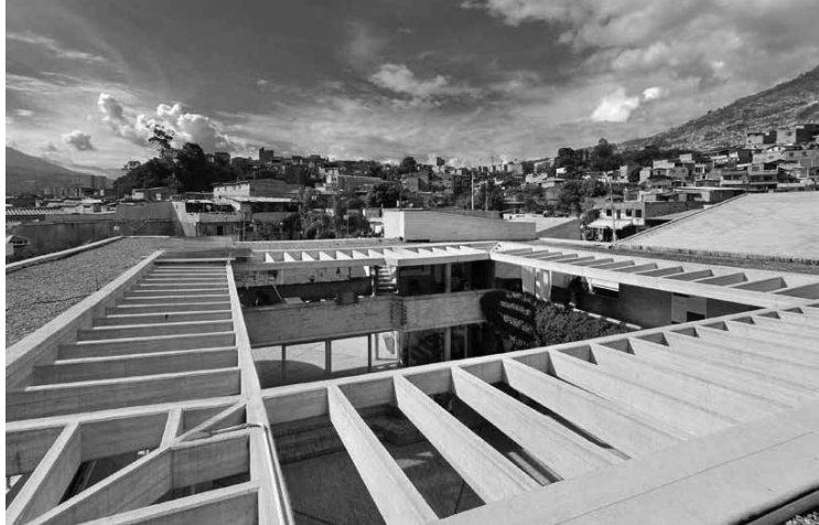
Panorámica de la estructura de cubiertas y pérgolas sobre el vacío del patio central, 2010. Fotografía: Ramiro Posada. ACMB/CDCM.
