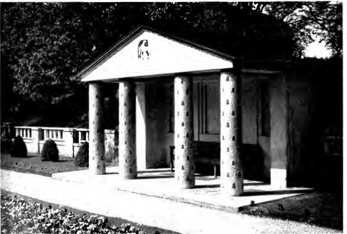
MAX LAUGER-KARLSRUHE • AU'S GARTEN 4 (VGL. S. 412) • GIEBELFELD VON BILDHAUER KARL ALBIKER-ETTLINGEN AUSFÜHRUNG DES GARTENHAUSES: BAUM & SCHÄFER, MANNHEIM; DER BANK MOBELFABRIK HAUSER, MANNHEIM
