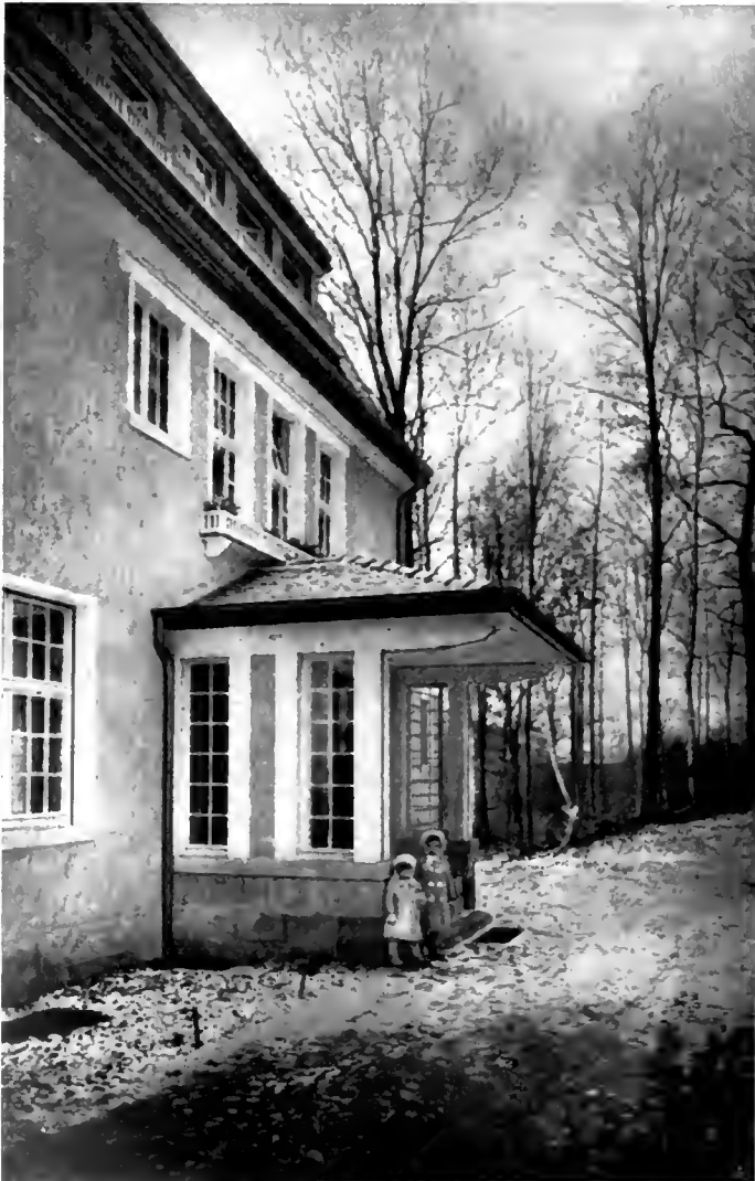
ARCH. MAX HANS KÜHNE-DRESDEN • VILLA MORAS: EINGANGSSEITE
