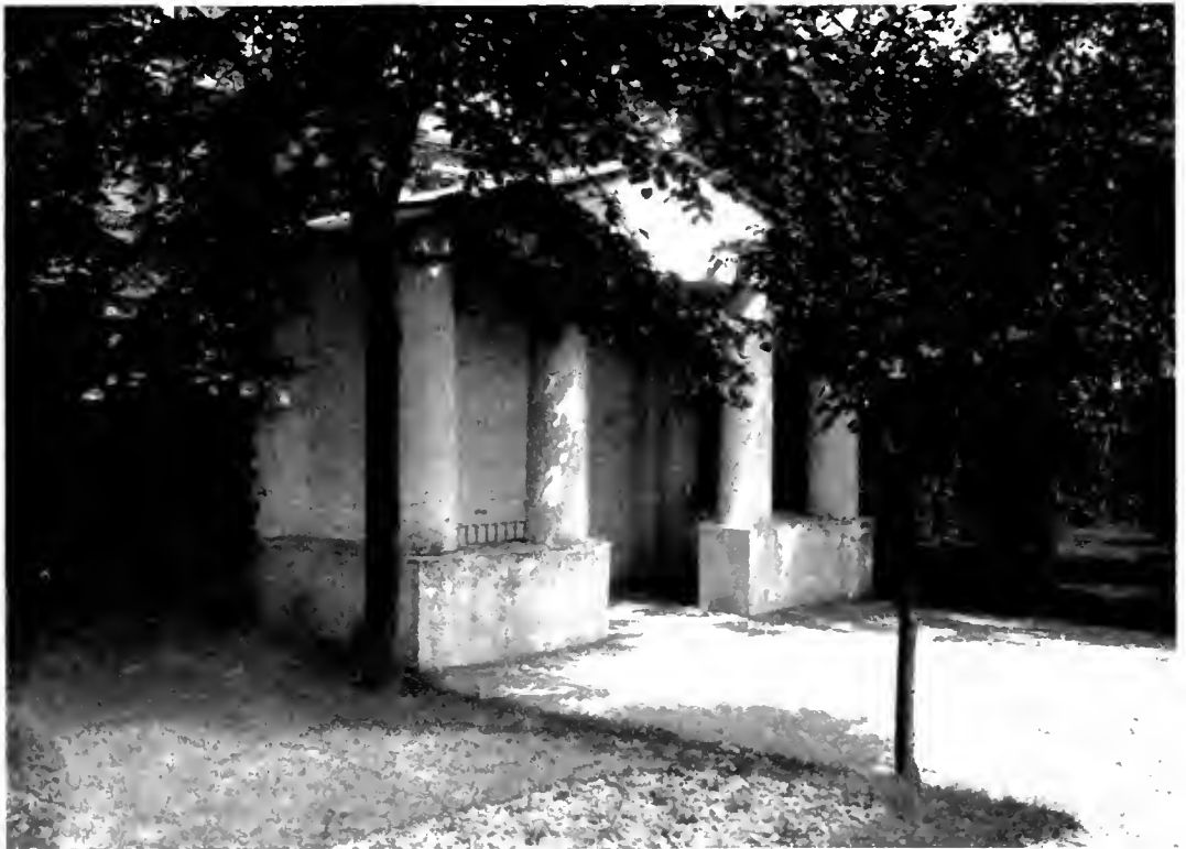
MAX LAUGER-KARLSRUHE • PERGOLA UND GARTENHAUS AUS DEM ROSENGARTEN LINKS VOM EINGANG
