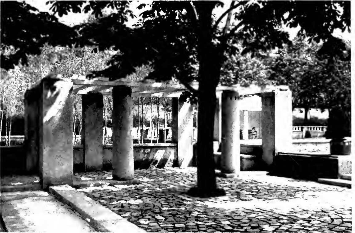
MAX LAUGER-KARLSRUHE AUFSE. DER PERGOLA: BAUM & SCHÄFER, MANNHEIM; DER TREPPEN HEIDELBERGER ZEMENTWAREN-INDUSTRIE PERGOLA AU'S GARTEN 2 (VGL. SEITE 418)
