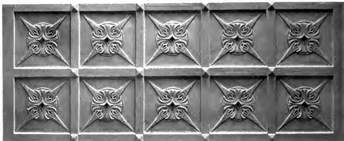
TEIL EINER STUCKDECKE
