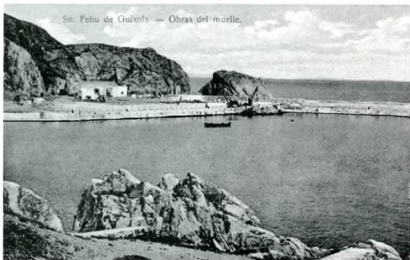
1. Obras del muelle (colorada).
