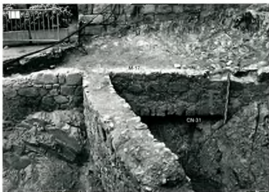
Fig. 8. Detall del tram nord del mur M-17, amb la situació de la canalització CN-31.
