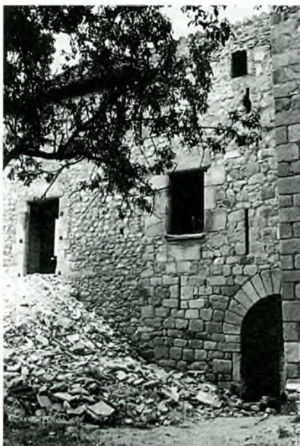
Fig. 3. Detall de les obres de restauració realitzades al castell a principis dels anys setanta. Autor: Lluís Esteva.
