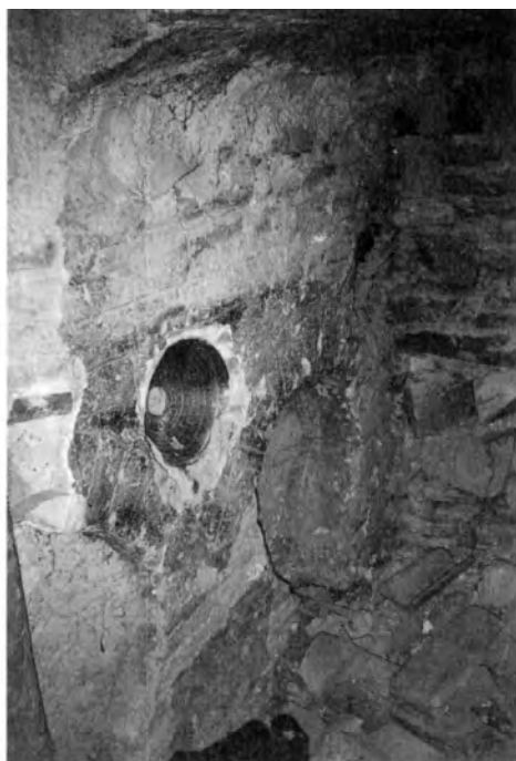
11. Lado norte, oculto, en la torre, mostrando el enlucido y esgrafiado de los arcos tímidos y un plato.
