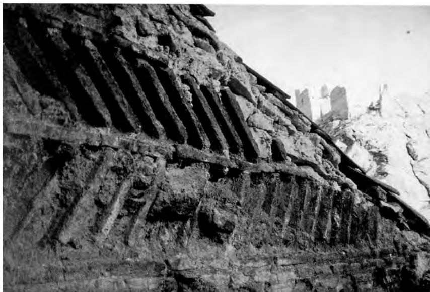
3. Detalle de la esquina de pez del lado SO.
