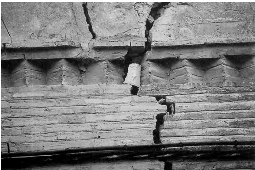
7. Transición entre la parte antigua y la ampliación.
