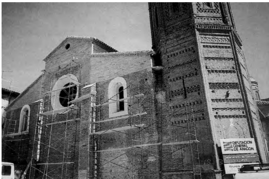
1. San Andrés, exterior durante la restauración.
