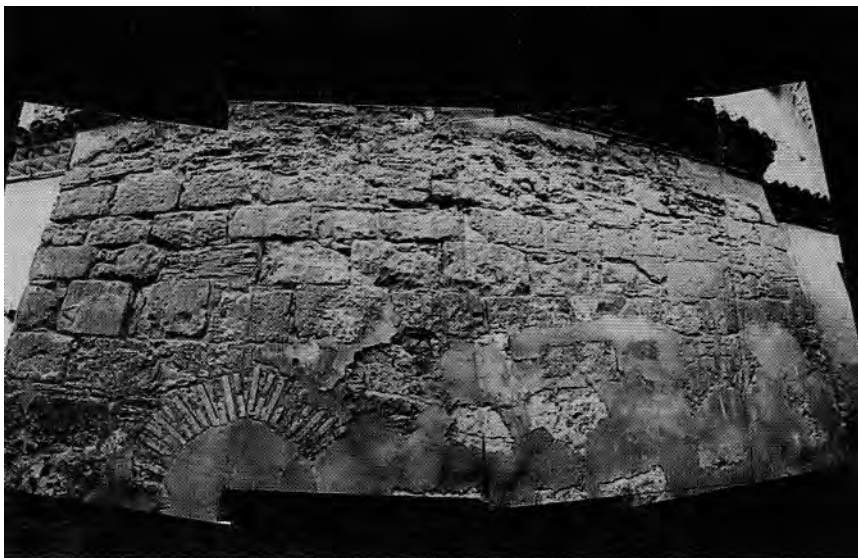
1. Fachada, antes de la restauración.
