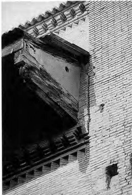
3. Encuentro de la torre y la iglesia.
