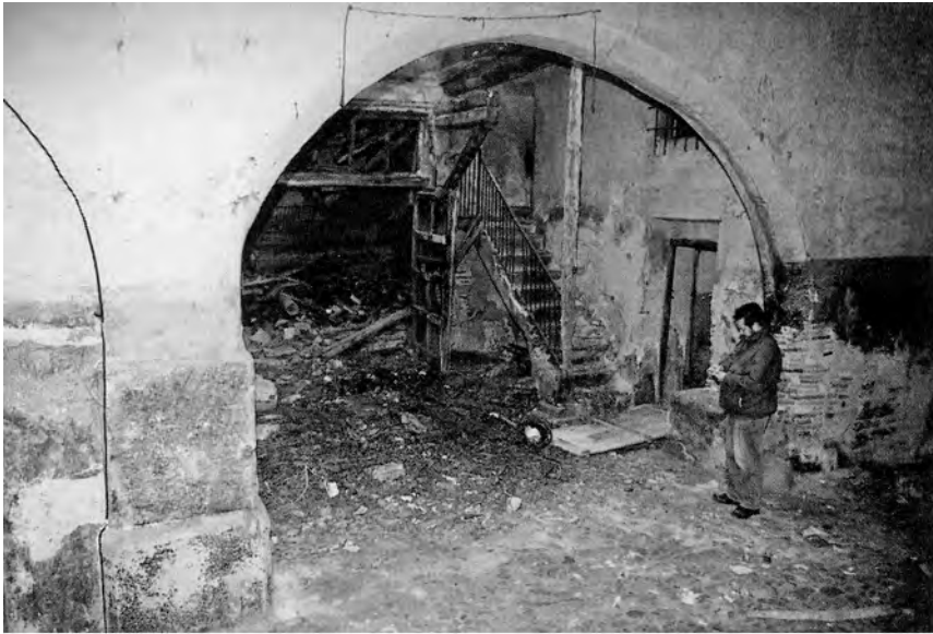
5. Arcos del patio. Se marca, a la izquierda, el arco tabicado.
