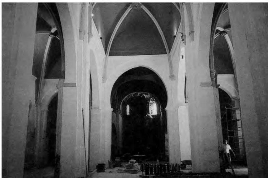
2. San Andrés, interior durante la restauración.
