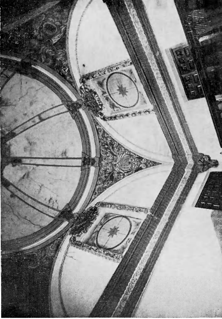
Seminario de San Carlos, Antigua Colegio de la Compañía. Bóveda de la escalera principal.
