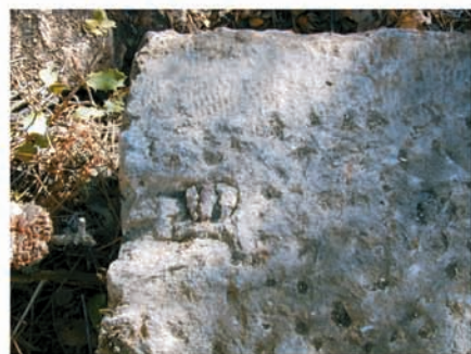
Vestige de scellement
