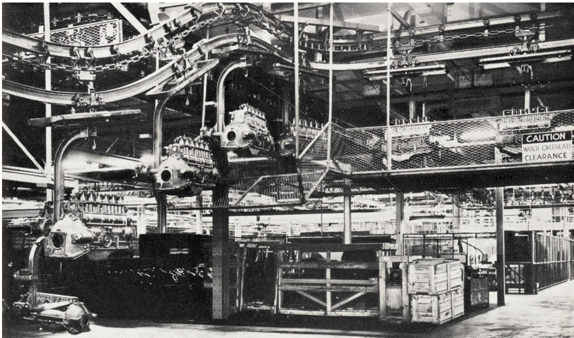
Transferstraße der Zylinderkopffertigung im Ford-Werk in Cleveland (1950)
