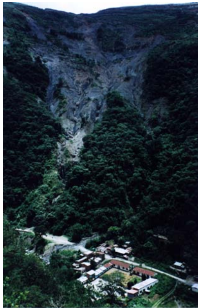
Figura 30. Derrumbes en el tramo km 32-36, y su amenaza respecto al camino y a la población de Pacallo (K. Allgoewer)
