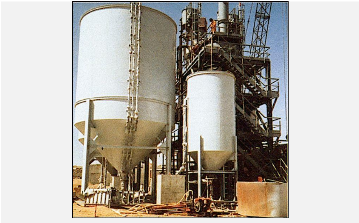
Σχήμα 2.3.4: Πύργος αναγέννησης ενεργού άνθρακα [52].
