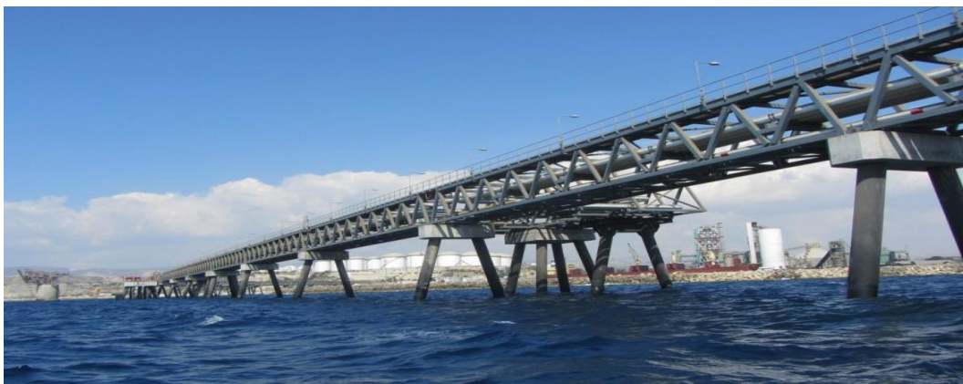
Εικόνα 26. Άποψη των εγκαταστάσεων της θαλάσσιας πλατφόρμας μεταφοράς καυσίμων (© Μ.Ρούσου). | Figure 26. Facilities of marine jetty (photo© M.Rousou).
