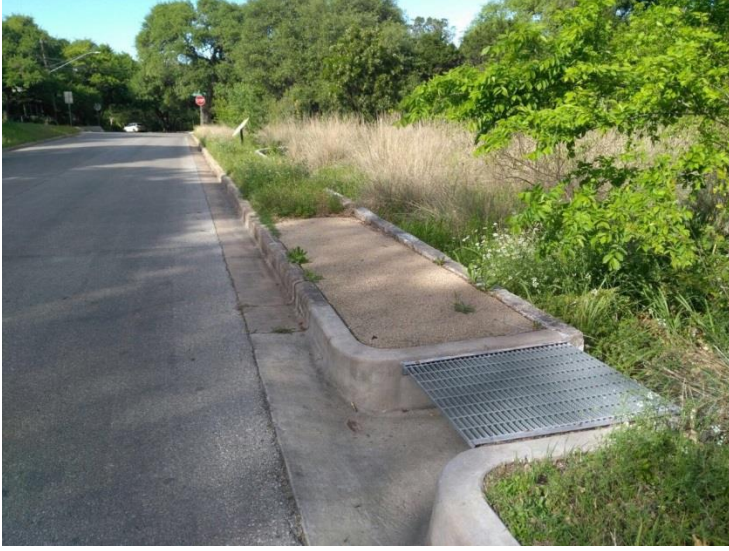
Şekil7: Yağmur sularının yönlendirilmesi amacıyla oluşturulan oluk
