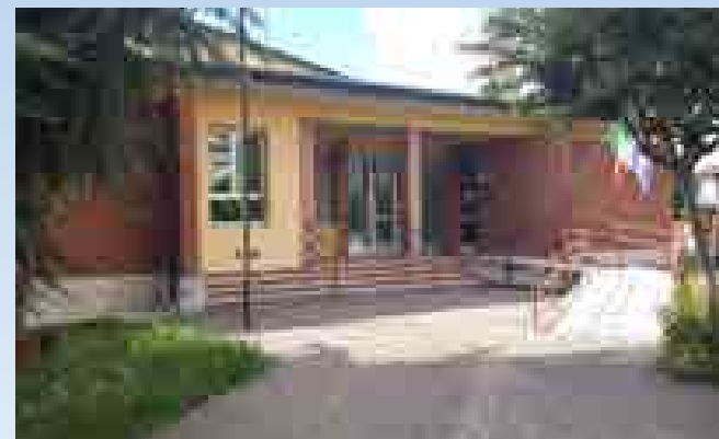
L'attuale scuola elementare cremosanesa sarà dismessa
