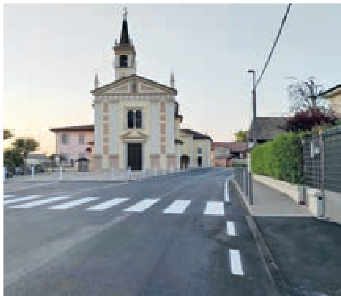
Il tratto centrale di Bolzone asfaltato nei giorni scorsi
